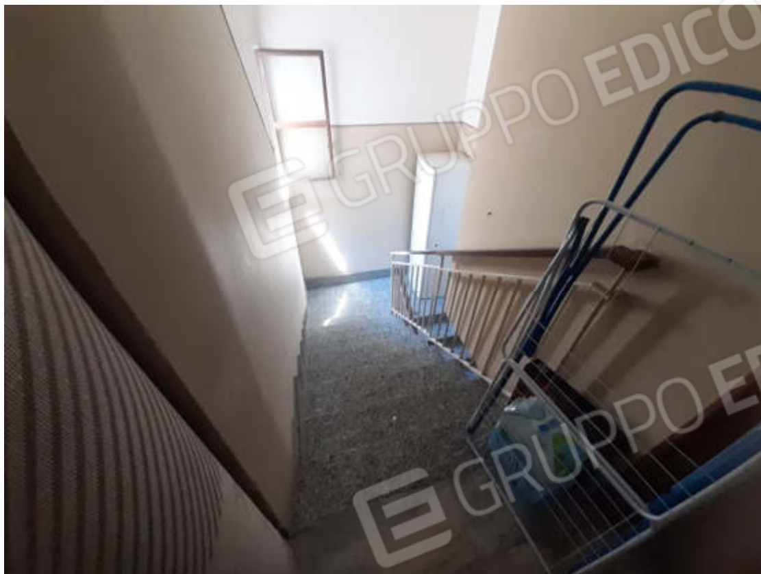
Vista interna del vano scala condominiale
