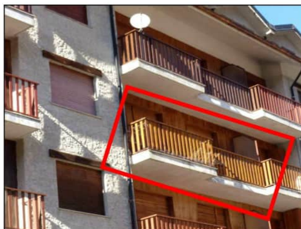
Fotografia n. 2 - Alloggio n. 730 sub 7
