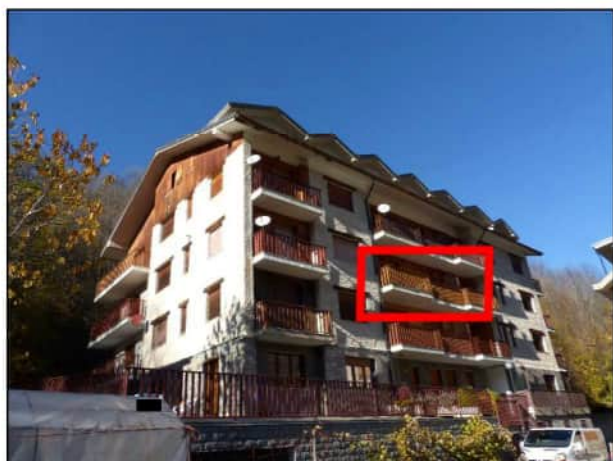
Fotografia n. 1 - Condominio La Rovere Ripresa della facciata principale – in evidenza l'alloggio n. 730 sub 7 al piano secondo.
