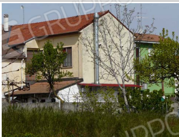
Foto n.46 Vista fabbricato da sud-est
