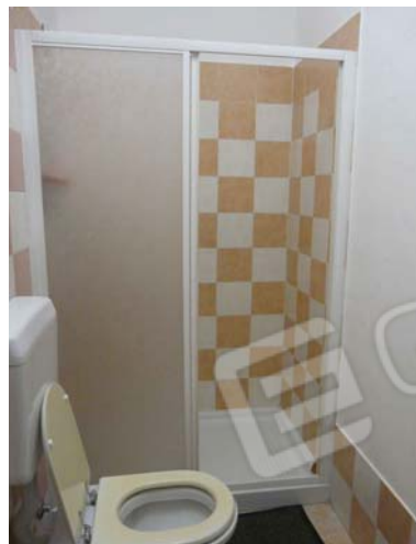
Foto n. 42 Bagno secondo piano
