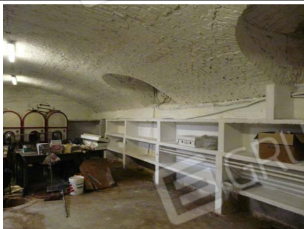
Foto n. 18 Cantina vano sottostante la sala ristorante lato sud
