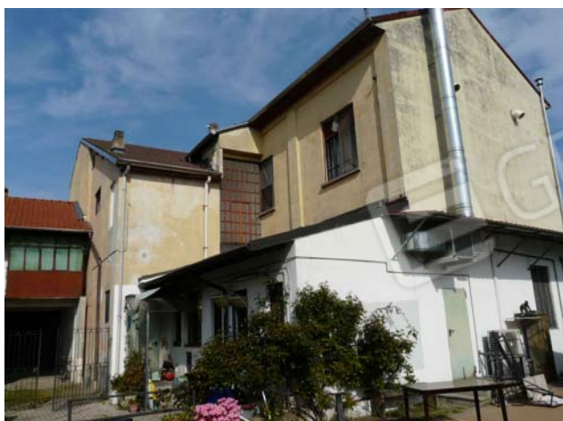
Foto n. 25 Facciata sud -est
