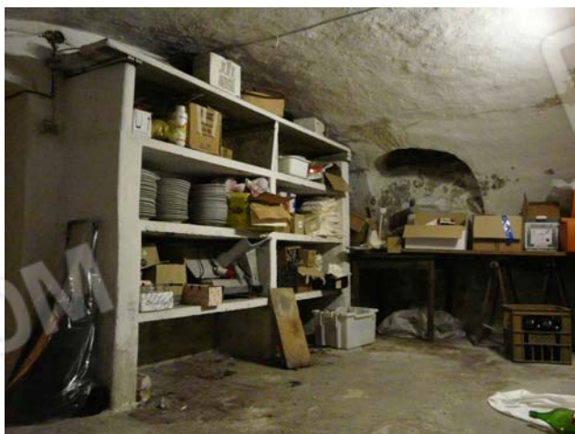
Foto n. 15 Cantina vano sottostante il bar
