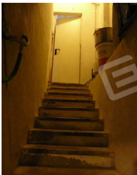
Foto n. 13 Scala di accesso alla cantina
