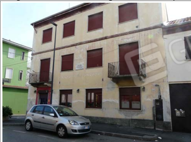
Foto n. 1 Facciata Ovest su Via Verbanò
