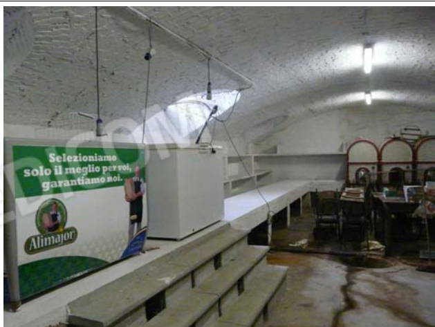
Foto n. 17 Cantina vano sottostante la sala ristorante lato nord
