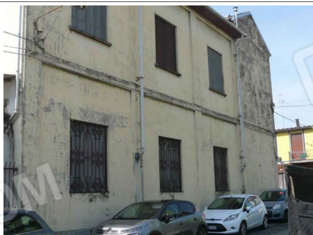
Foto n. 45 facciata Nord su Via Garzulano
