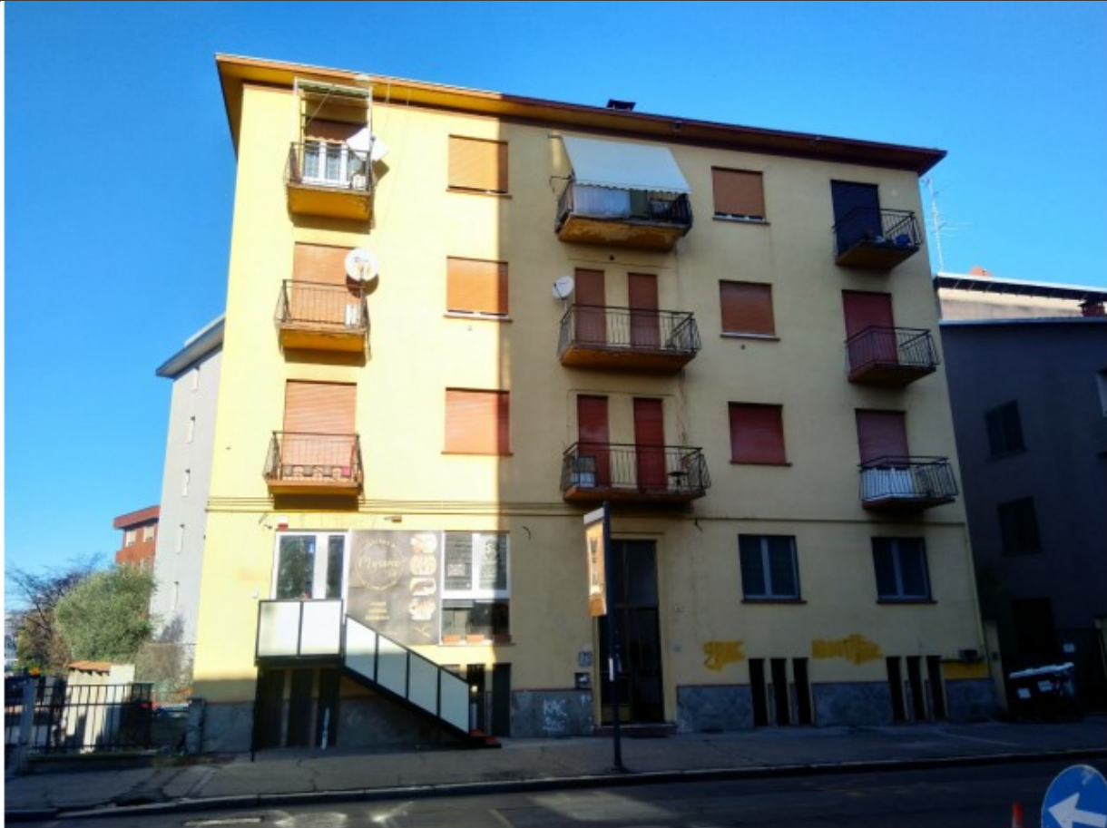
Vista esterna: ingresso dalla pubblica viabilità, Corso Vercelli 66
