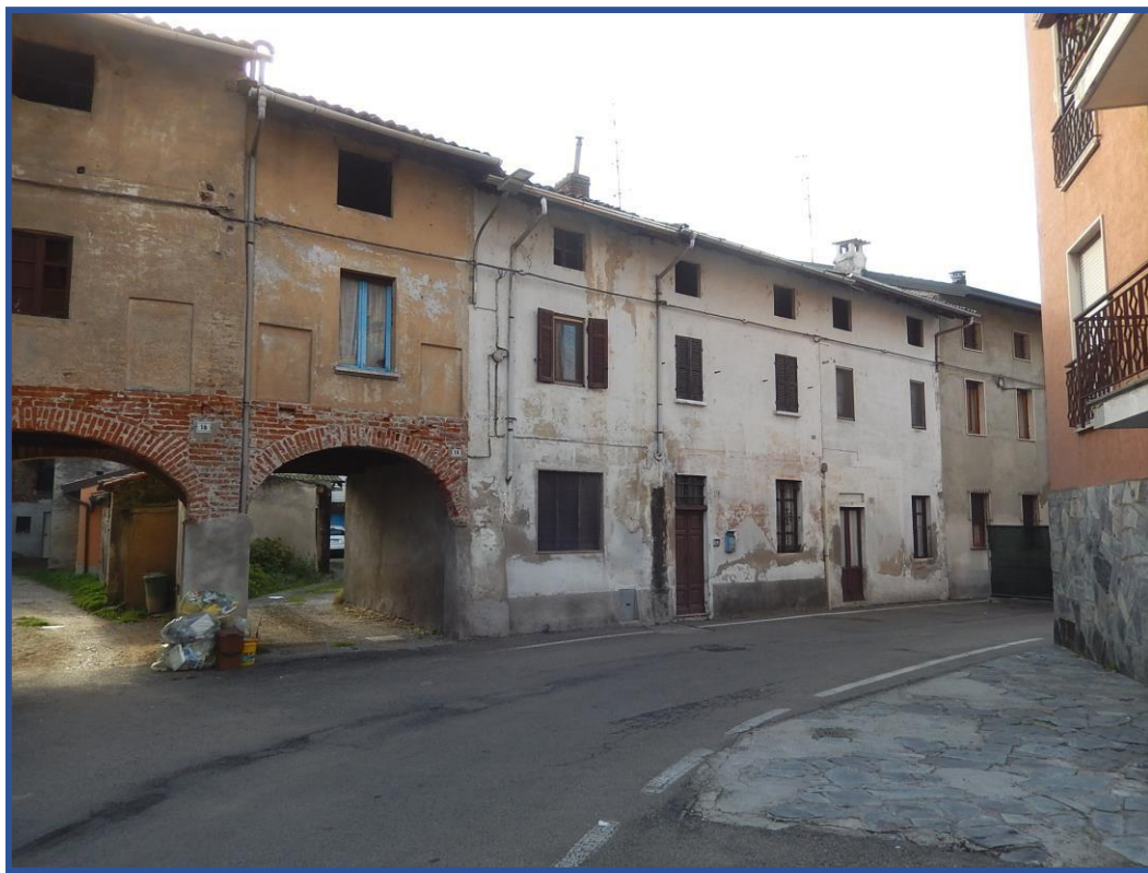
Vista d'insieme del fabbricato da via B. Cairoli n° 14 – lato Nord/Ovest
