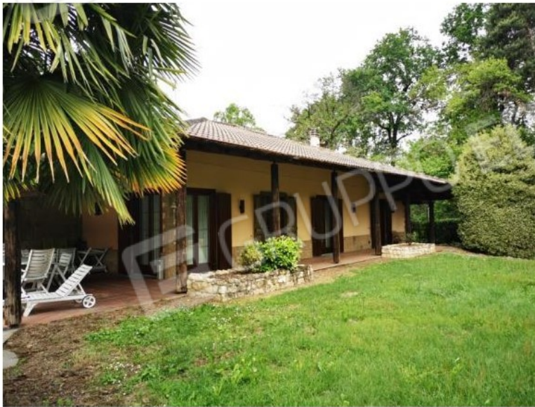
Residenza - Portico - fronte di nord est
