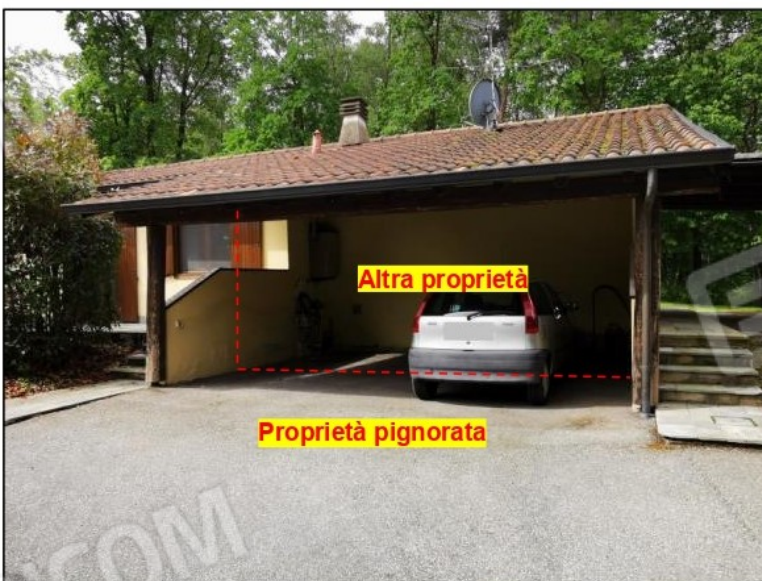
Porzione di tettoia
