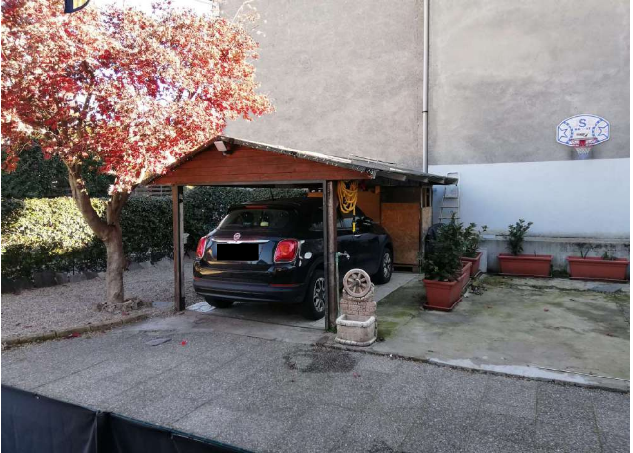
FOTO 17 – TETTOIA NON AUTORIZZATA
