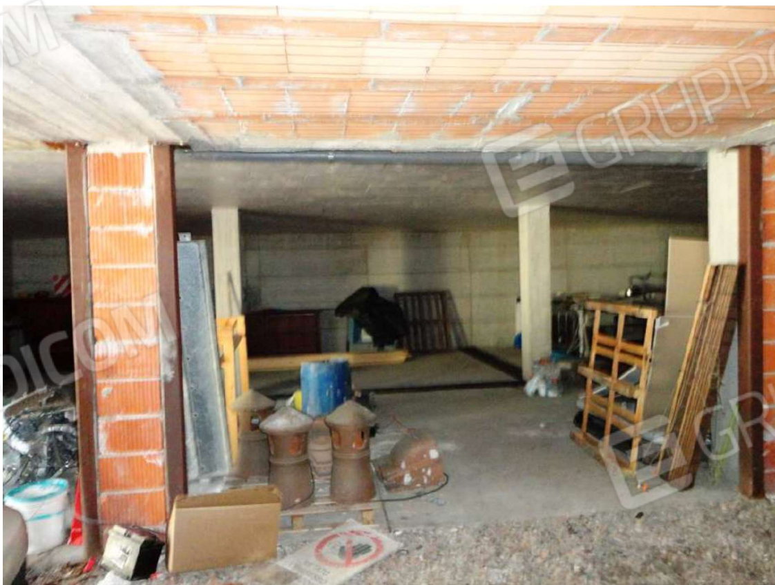
Foto 12: Vista interna dell'immobile – Piano Interrato – locale in corso di costruzione Foglio 21 mappale 1707 sub 5
