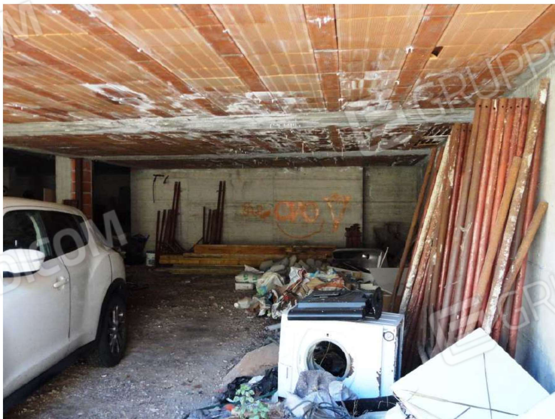
Foto 8: Vista interna dell'immobile – Piano Interrato – locale in corso di costruzione Foglio 21 mappale 1707 sub 5
