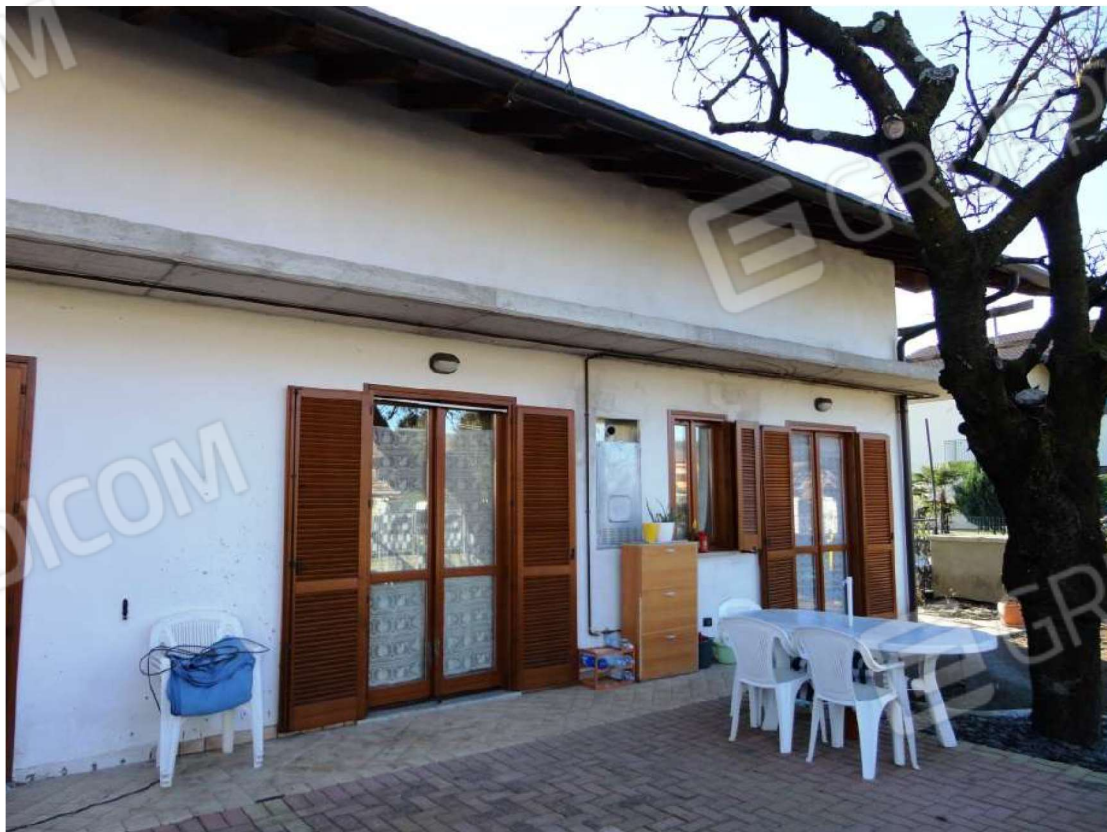
Foto 4: Vista esterna dell'immobile – Piano Terra Foglio 21 mappale 1707 sub 1
