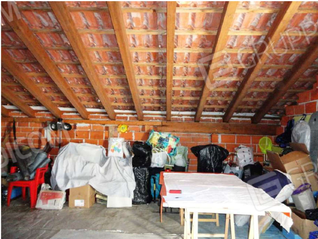
Foto 14: Vista interna dell'immobile – Piano Primo – Magazzino nel sottotetto Foglio 21 mappale 1707 sub 3
