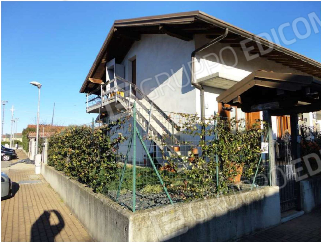
Foto 1: Vista esterna dell'immobile – Piano Terra Foglio 21 mappale 1707 sub 1
