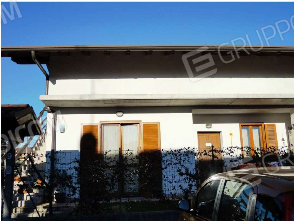
Foto 2: Vista esterna dell'immobile – Piano Terra Foglio 21 mappale 1707 sub 1
