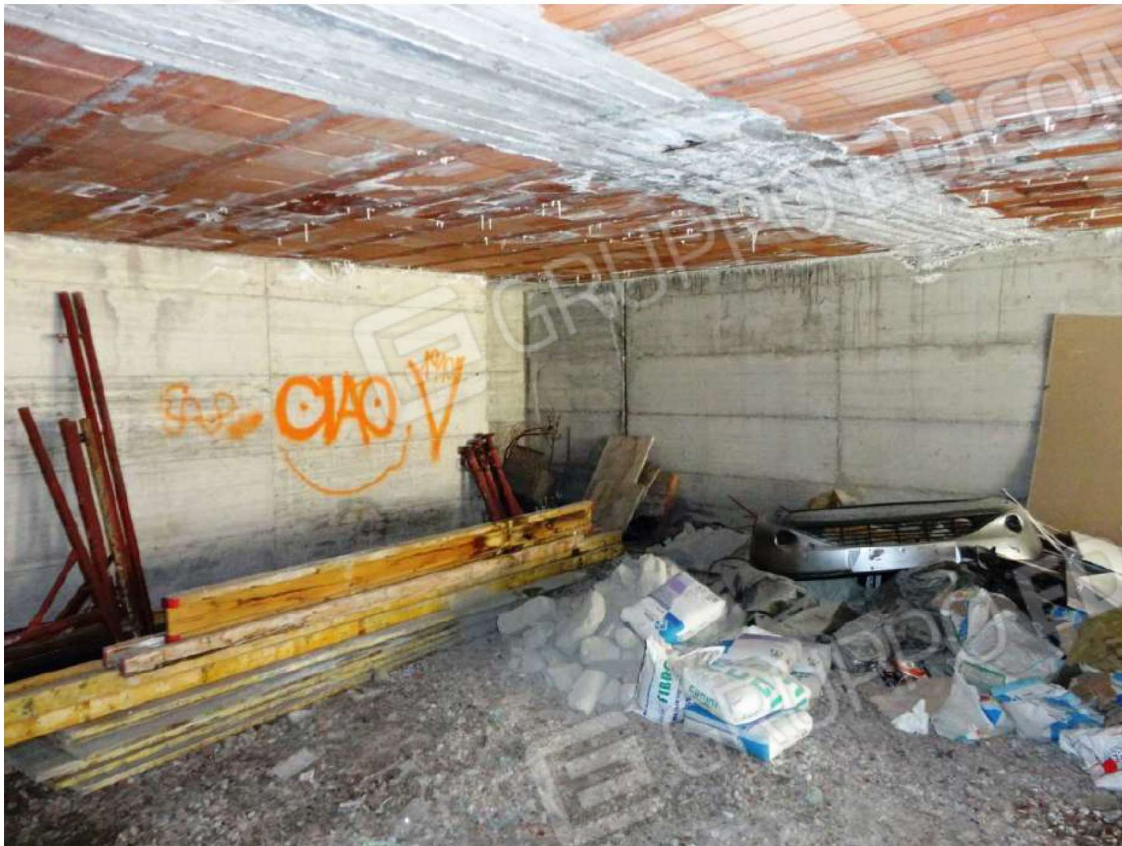
Foto 11: Vista interna dell'immobile – Piano Interrato – locale in corso di costruzione Foglio 21 mappale 1707 sub 5
