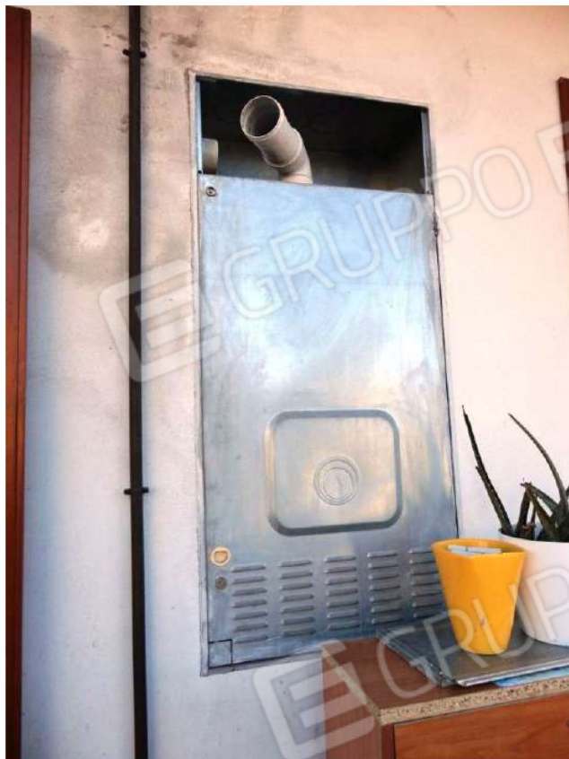
Foto 7: Vista esterna dell'immobile – Piano Terra – caldaia ad incasso a metano Foglio 21 mappale 1707 sub 1
