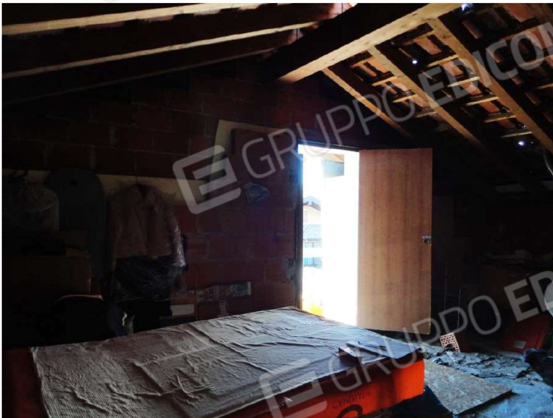
Foto 17: Vista interna dell'immobile – Piano Primo – Magazzino nel sottotetto Foglio 21 mappale 1707 sub 3
