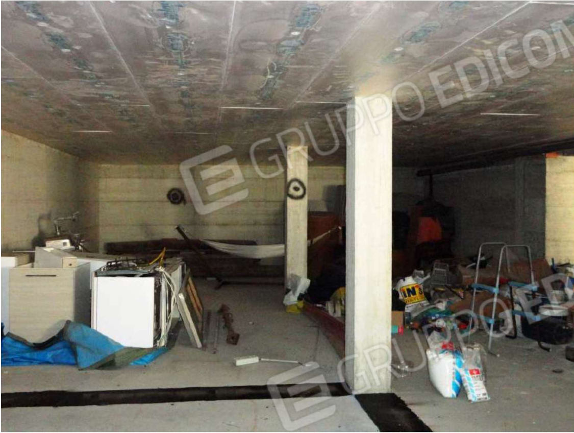
Foto 9: Vista interna dell'immobile – Piano Interrato – locale in corso di costruzione Foglio 21 mappale 1707 sub 5
