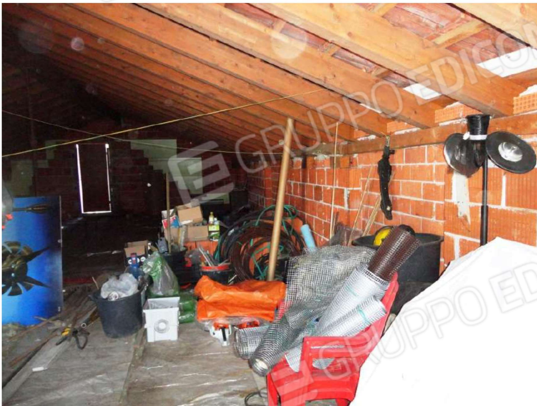
Foto 15: Vista interna dell'immobile – Piano Primo – Magazzino nel sottotetto Foglio 21 mappale 1707 sub 3
