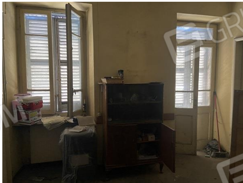
Foto 17: Appartamento –Finestre soggiorno.
