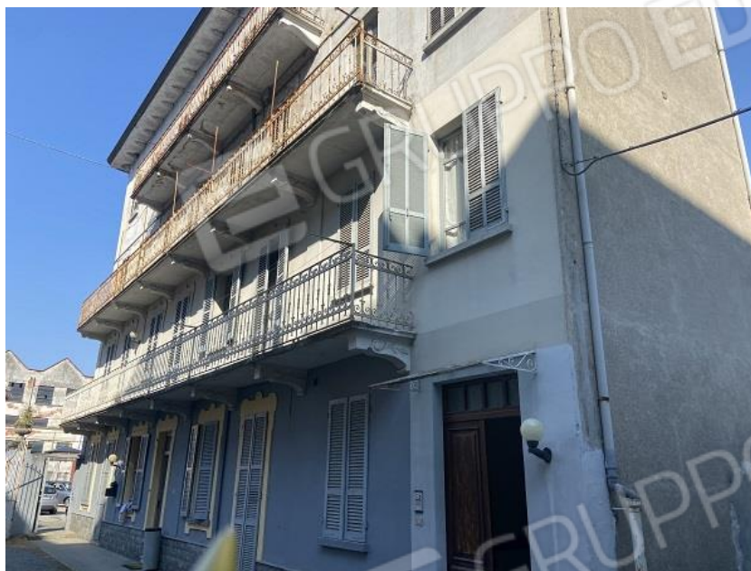
Foto 4: Prospetto sud/est piano terra e primo .
