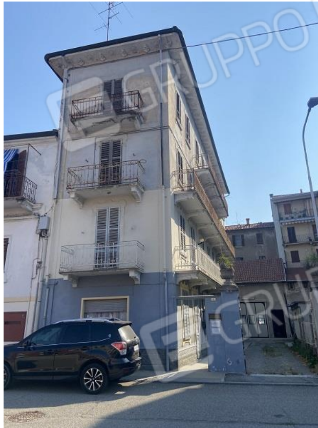
Foto 2: Prospetto ovest su via Spianata Fiera n. 6
