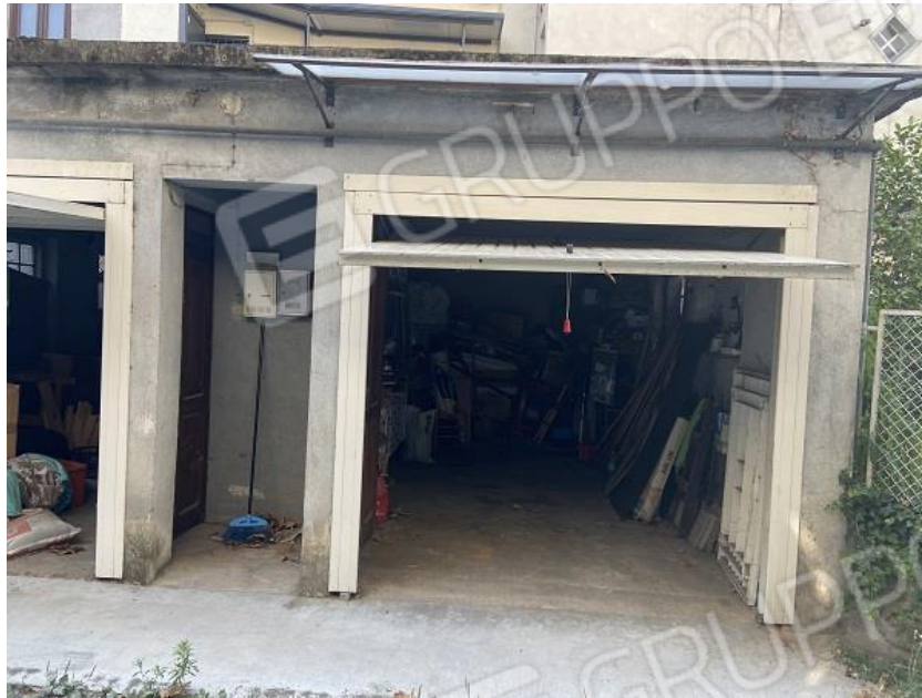
Foto 28: Autorimessa al sub. 3.
