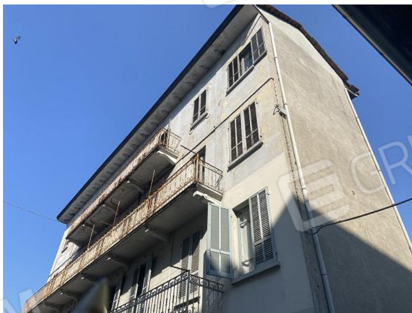
Foto 5: Prospetto sud/est piano secondo e terzo.
