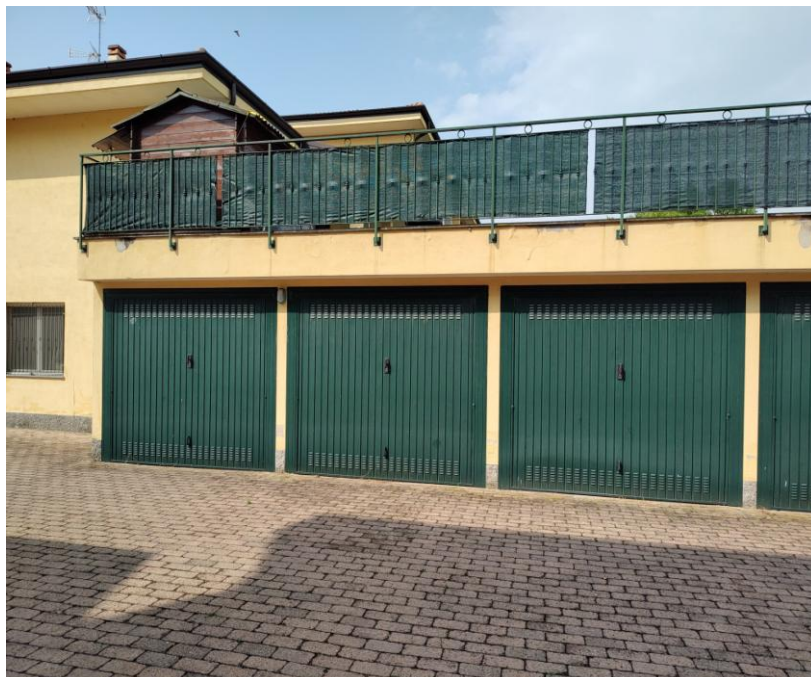
Unita' immobiliare al piano interrato (basculante centrale).
