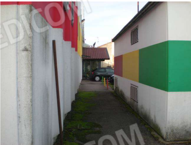
Foto 6 cabina ENEL posizione
