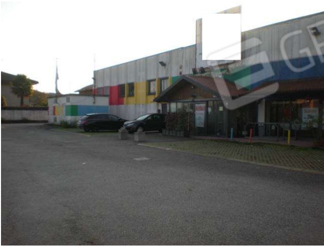
Foto 1 vista ingresso da parcheggio
