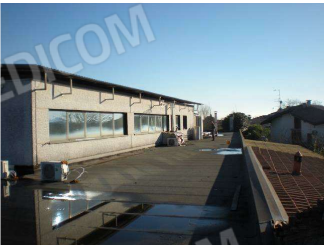
Foto 42 lato ovest deposito e adiacenze altre proprietà
