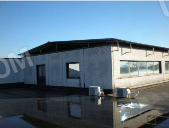
Foto 41 vista deposito 1°P.
