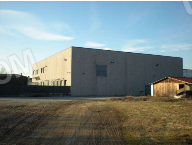
Foto 11 vista complessiva capannone lati est-sud
