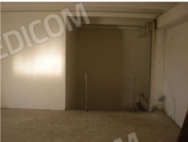
Foto 30 deposito 1°P. vuoto su solaio
