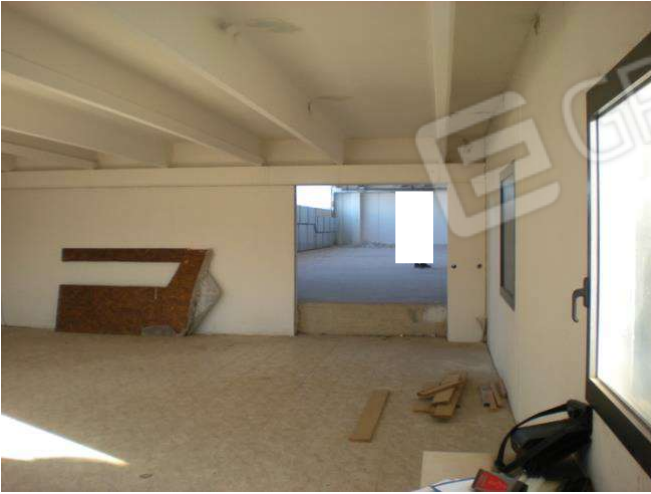
Foto 31 deposito 1°P. con passaggio spazio "non accessibile"
