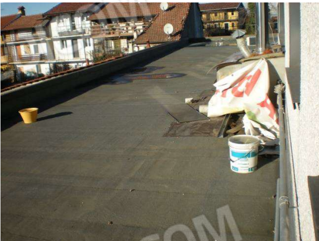
Foto 33 solaio di copertura lato ovest
