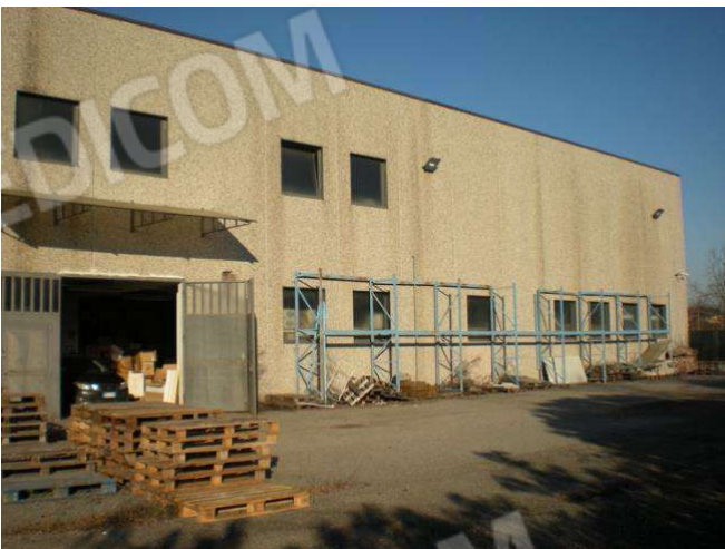
Foto 9 lato sud vista da cortile
