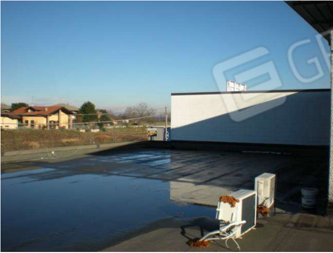
Foto 40 vista lato strada da copertura sopra zona bar
