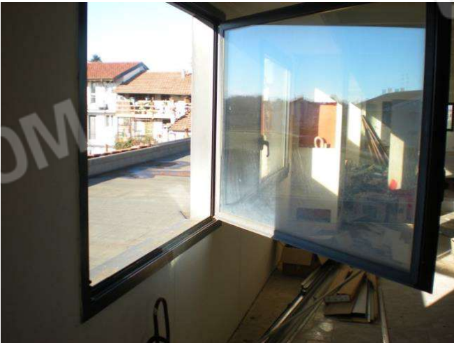
Foto 32 deposito 1°P. vista solaio di copertura
