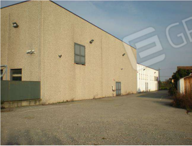
Foto 7 lato est parte ampliamento
