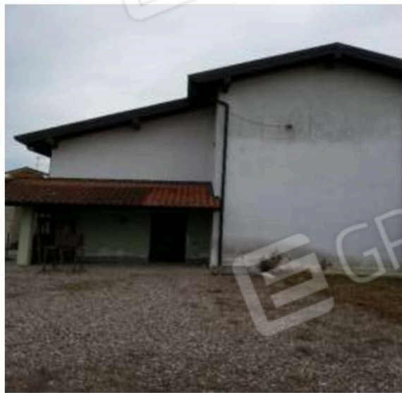
ingresso F35 mapp.327 sub 10
