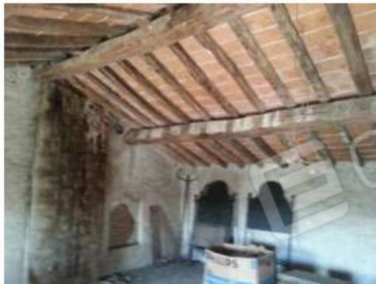
Granaio F35 mapp.327 sub 9 -centrale
