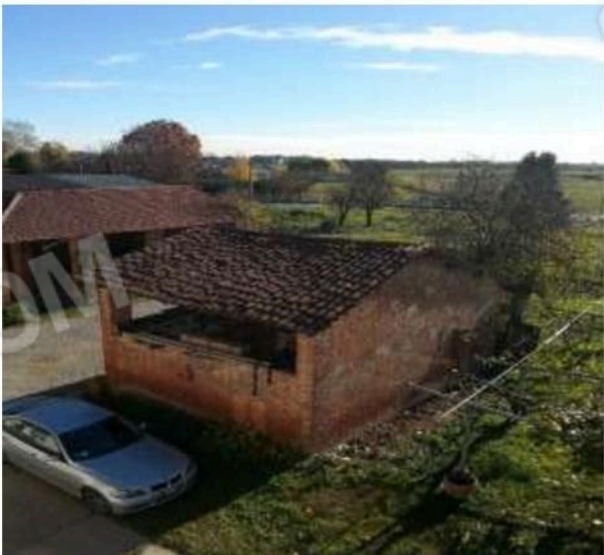
Edificio F 35 mapp. 327 sub 6 vista da nord
