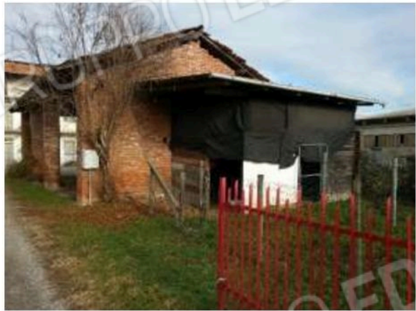
Edificio F 35 mapp. 327 sub 7 vista da sud
