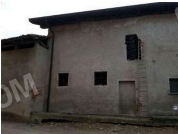
Edificio prospetto nord
