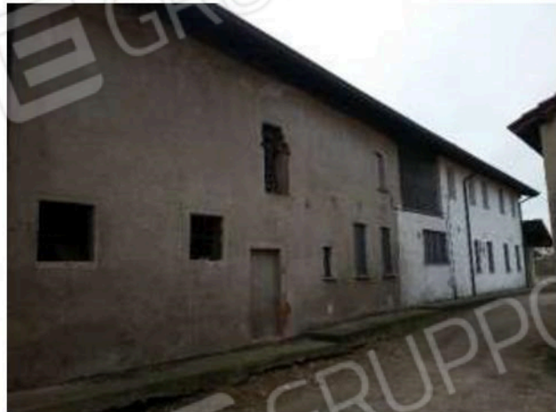
edificio prospetto nord
