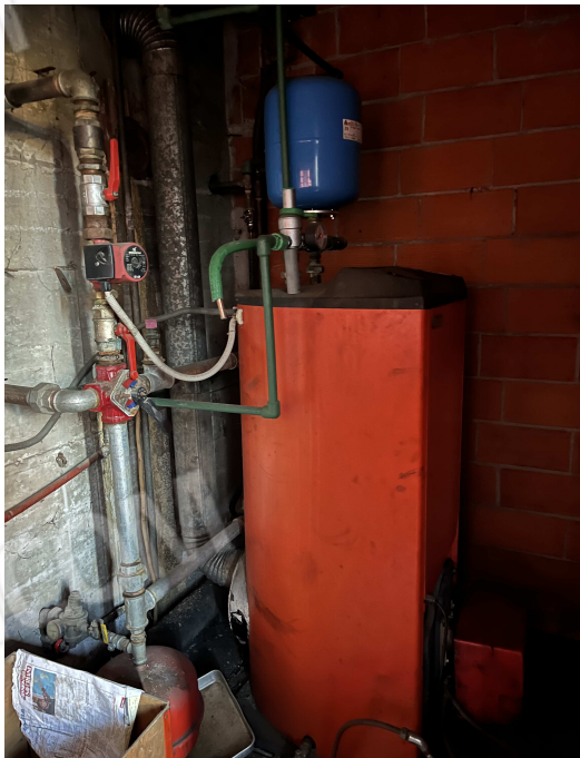
30-31. Riprese fotografiche della caldaia a gasolio e del pozzetto di chiusura dell'alloggiamento della cisterna per il gasolio interrata
