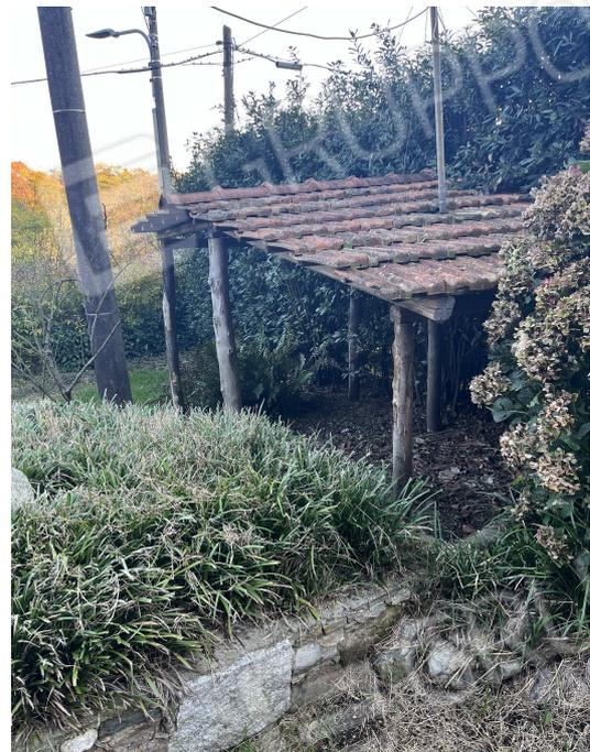
**42-43. Riprese fotografiche del prospetto est e della tettoia (dalla struttura in legno molto precaria) realizzata abusivamente e che dovrà essere demolita**
