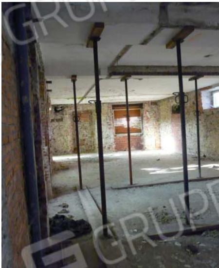
Foto 13 Interno sub 3 piano primo orientamento sud-ovest
