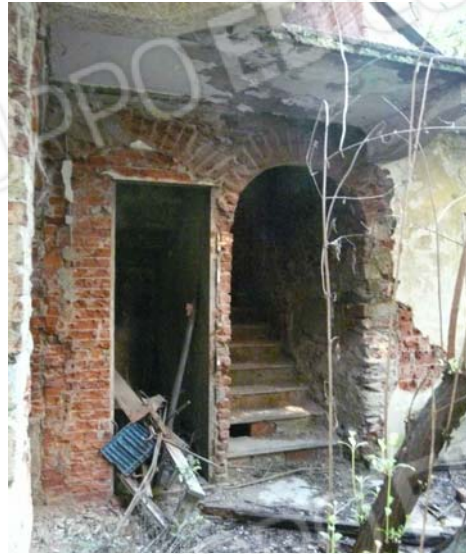
Foto 18 Vano scala comune piano terra a lato cantine
