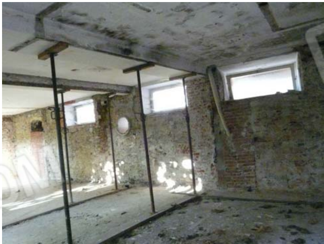
Foto 12 Interno sub 3 al piano primo orientamento ovest
