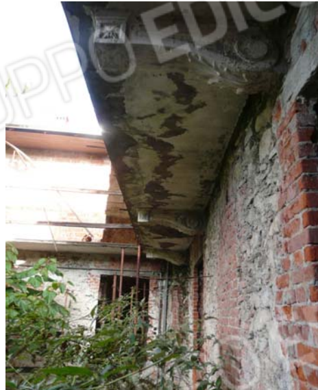
Foto 24 Facciata sud sub 2 verso la corte comune intradosso balcone piano secondo
