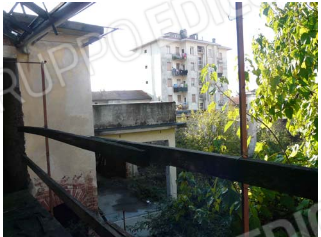
Foto 30 vano scala al piano secondo
