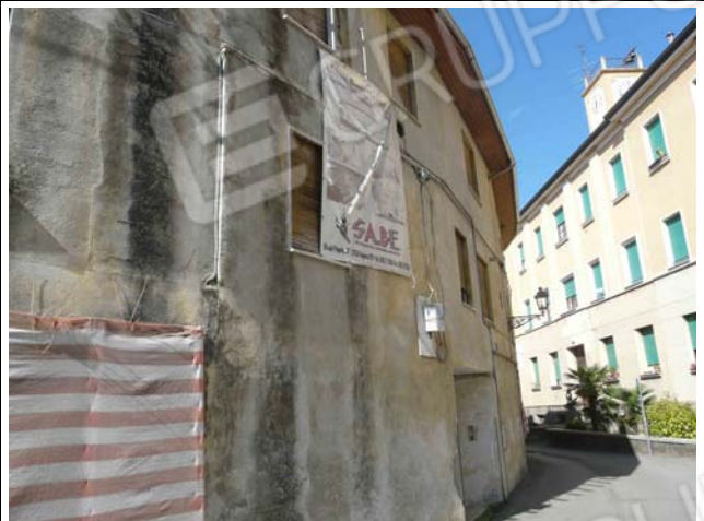
Foto n.3 Facciata Nord su Via Don Guanella seconda porzione
