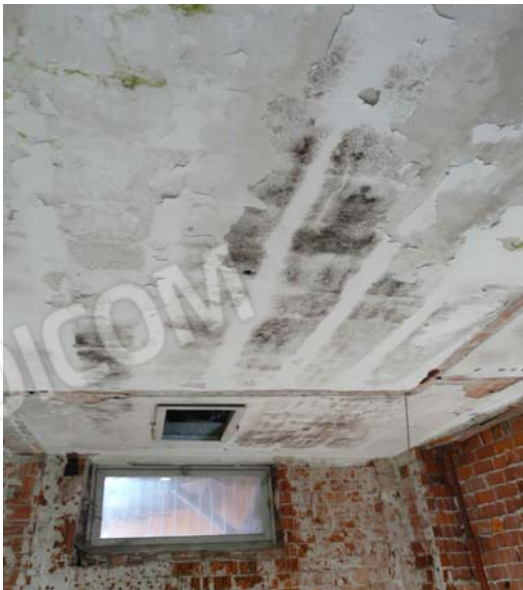
Foto 33 intradosso solaio piano secondo sub 11
