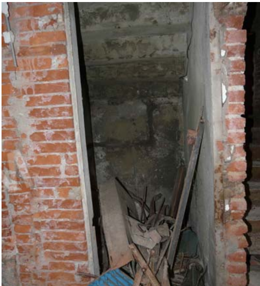
Foto 19 Sottoscala piano terreno
