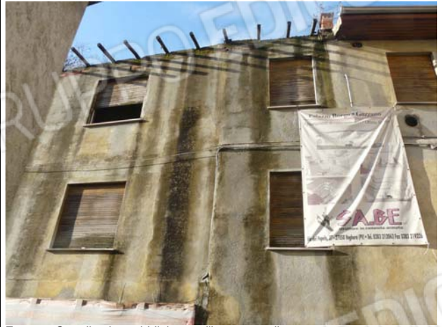
Foto n.5 Cartello che pubblicizzava l'intervento di recupero
