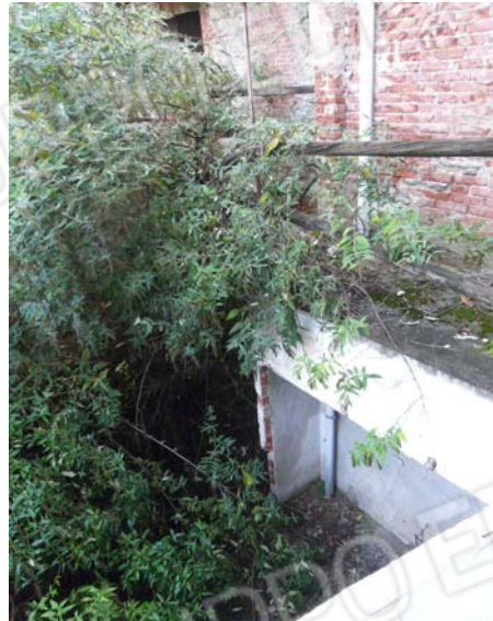
Foto 11 facciata sud vano scala e ballatoio di accesso al sub 11
