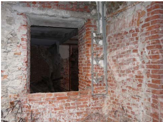
Foto 10 Facciata est sub 7 verso corte comune
