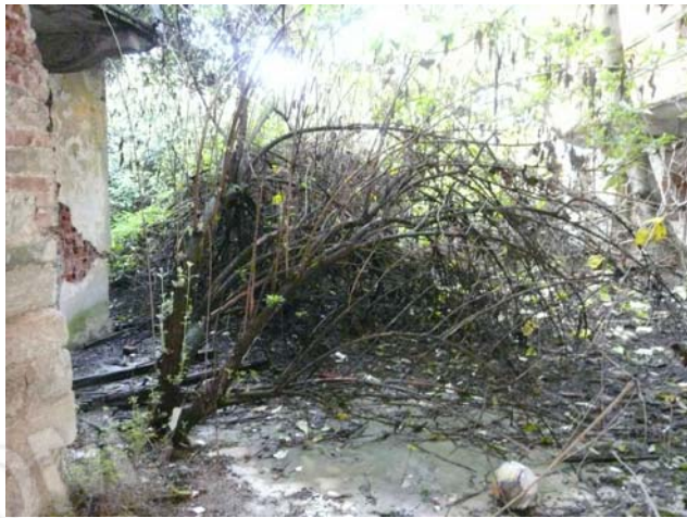
Foto 6 Corte Comune vista dall'androne carraio
