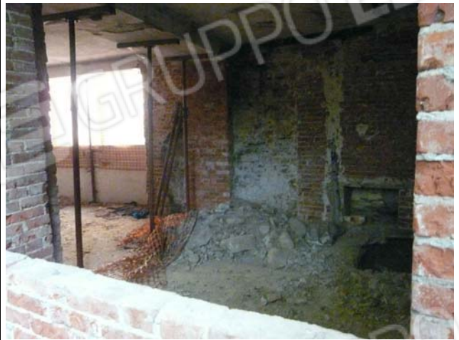
Foto 7 Interno magazzino sub. 7 piano terreno
