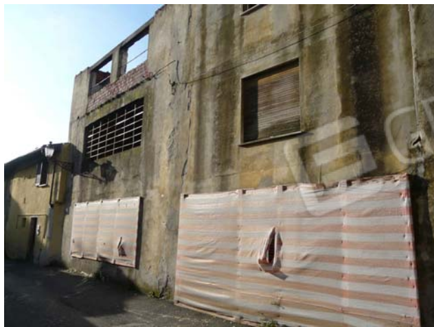
Foto 4 Facciata nord su Via Don Guanella terza porzione
