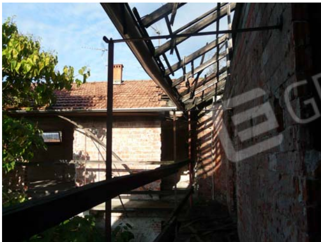
Foto 29 Facciata sud-est piano secondo
