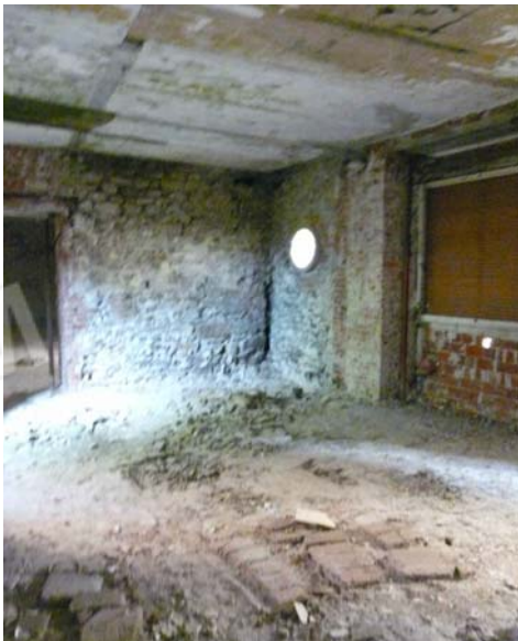
Foto 25 Interno magazzino piano primo sub 11
