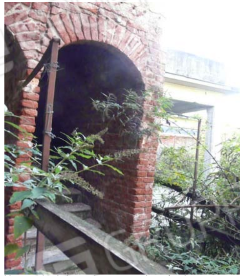
Foto 20 Vano scala al piano primo con porzione facciata ovest magazzino sub 11
