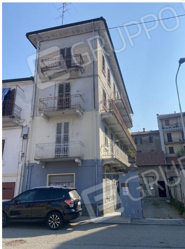
Foto 2: Prospetto ovest su via Spianata Fiera n. 6
