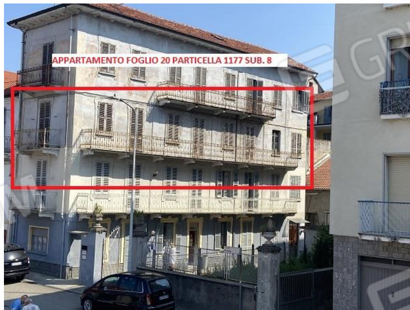
Foto 1: Prospetto sud/ovest principale sul cortile interno e su via Spianata Fiera n. 6.
