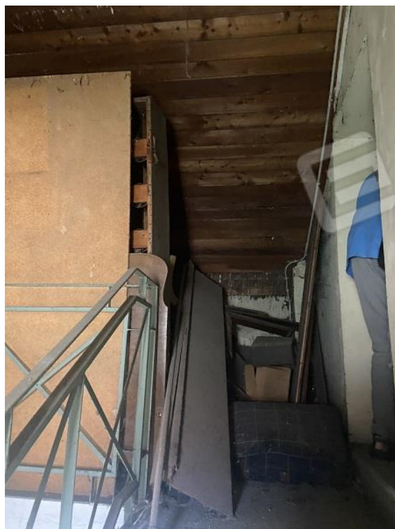
Foto 23: Ingresso alla soffitta condominiale.
