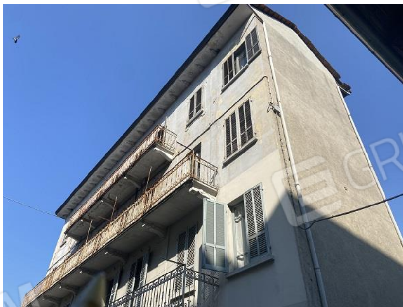
Foto 5: Prospetto sud/est piano secondo e terzo.
