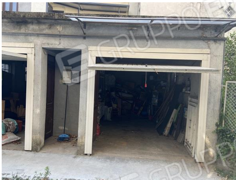
Foto 28: Autorimessa al sub. 3.
