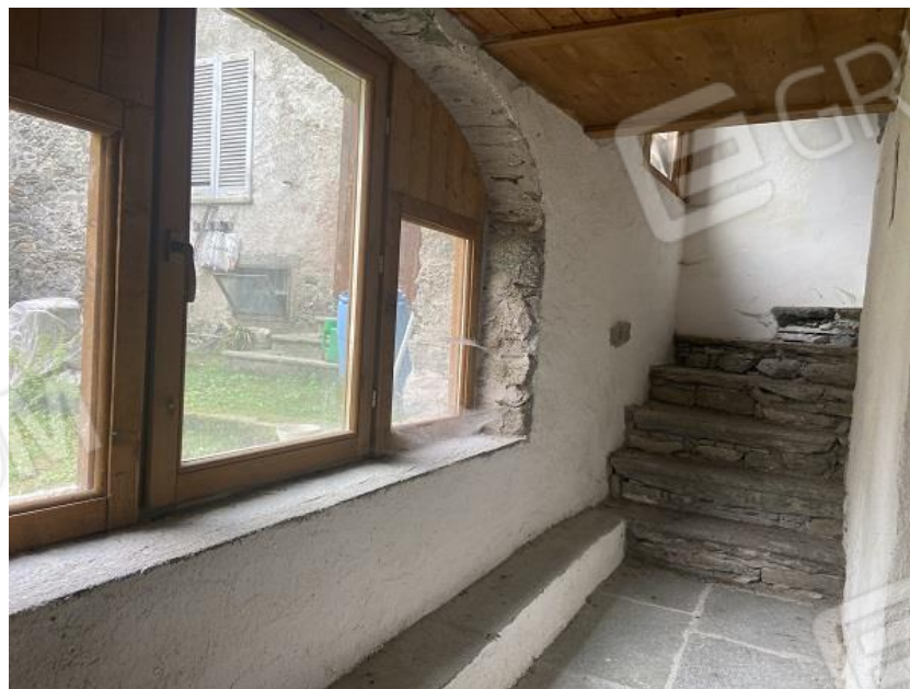
Foto 15: Prima parte di appartamento – Scala di accesso alla cantina con il portico che è stato chiuso.
