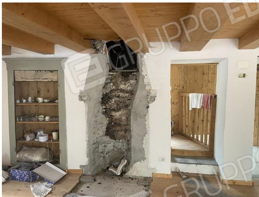
Foto 10: Prima parte di appartamento – Cucina / Pranzo con scasso per camino e accesso al disimpegno aperto del bagno.
