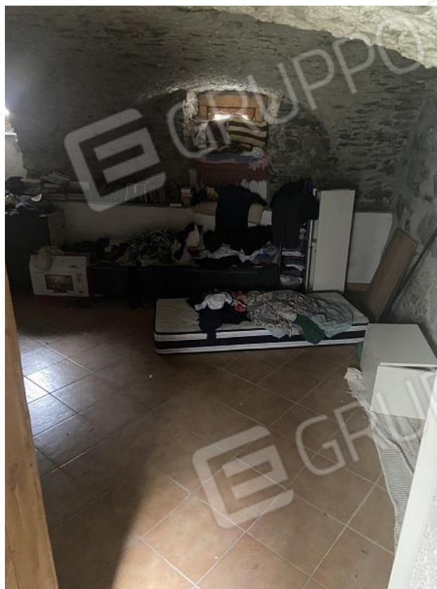
Foto 16: : Prima parte di appartamento – Cantina.
