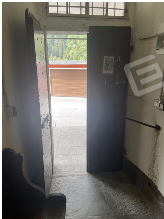
Foto 5: Porta di ingresso comune dal portico su strada vista dall'interno.
