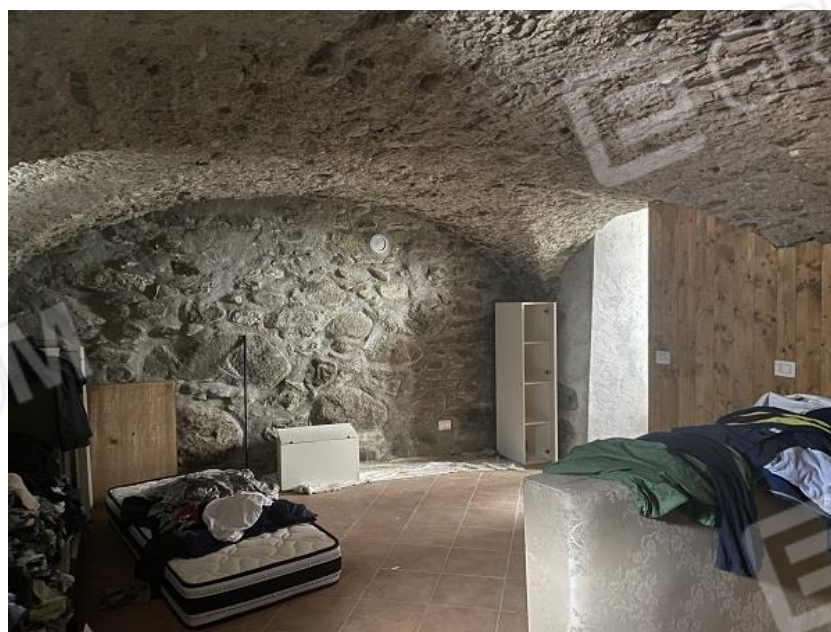
Foto 17: Prima parte di appartamento – Cantina.
