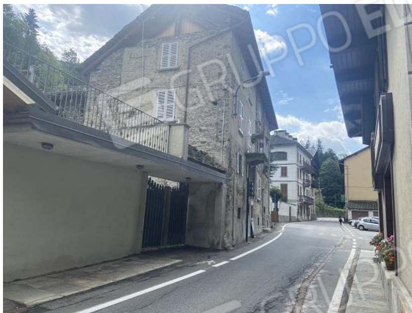
Foto 2: Prospetto sud/ovest visto da corso Umberto I.
