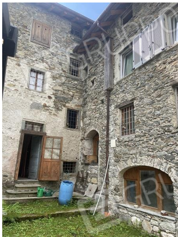
Foto 28: Cortile comune – in basso sulla destra il portico che è stato chiuso con un serramento.
