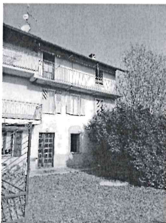
Particolare fronte sud – corte
