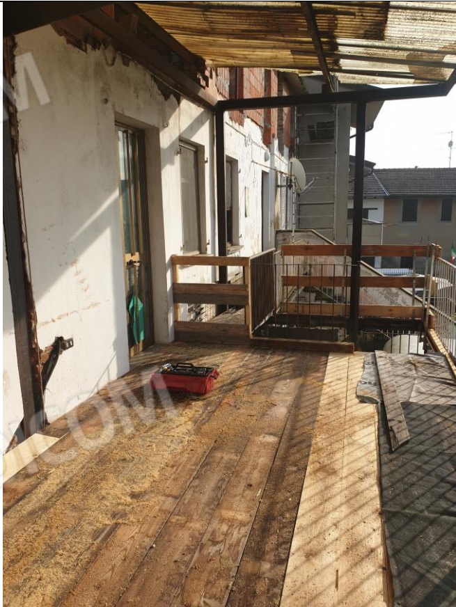
Foto 05: Accesso da ballatoio ampliato piano primo
