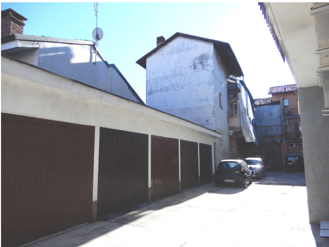
Vista da Via Mazzini – cortile su cui insiste l'ingresso al compendio pignorato
