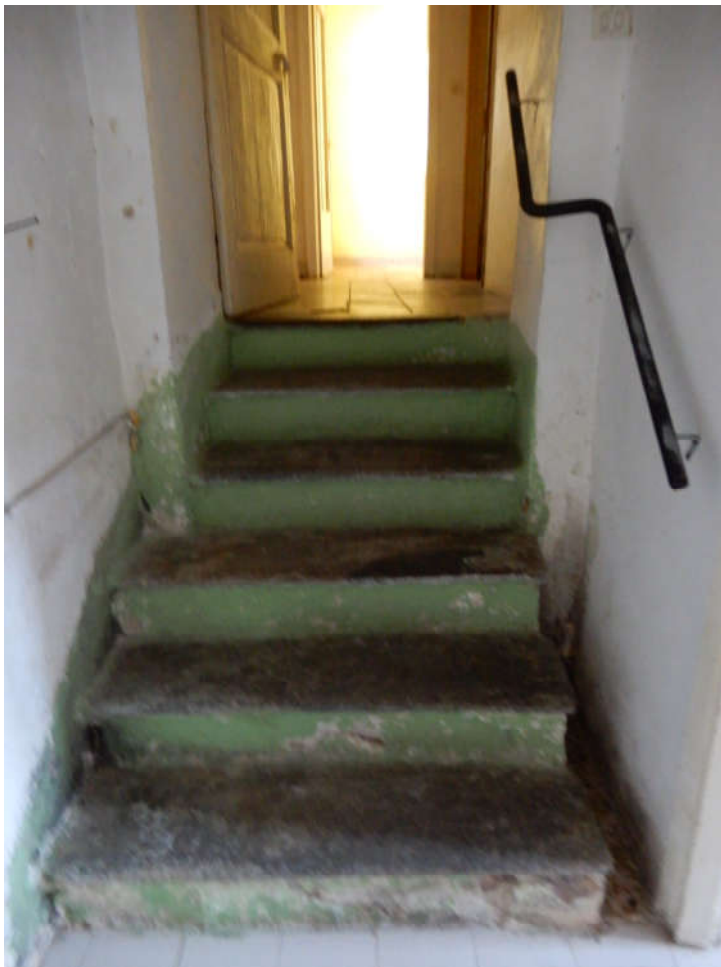
Piano terra scala di collegamento fra zona giorno e zona notte Da ingresso/cucina
