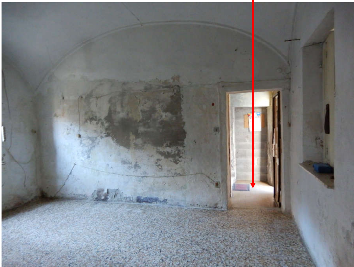
Piano terra – ingresso/cucina
