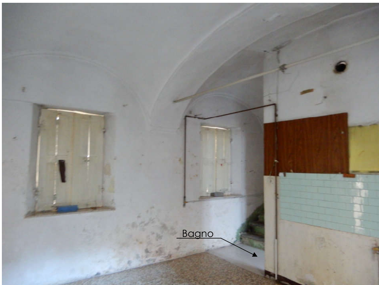
Piano terra – ingresso/cucina
