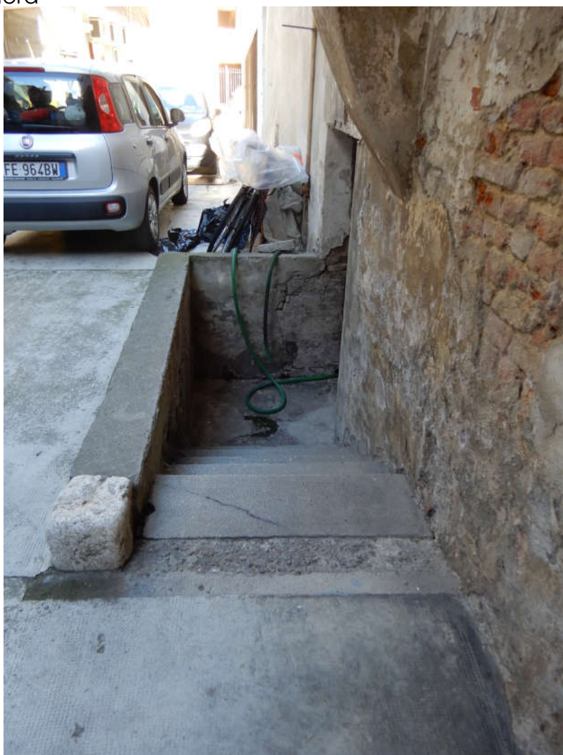
Piano terreno, scala di accesso alla cantina
