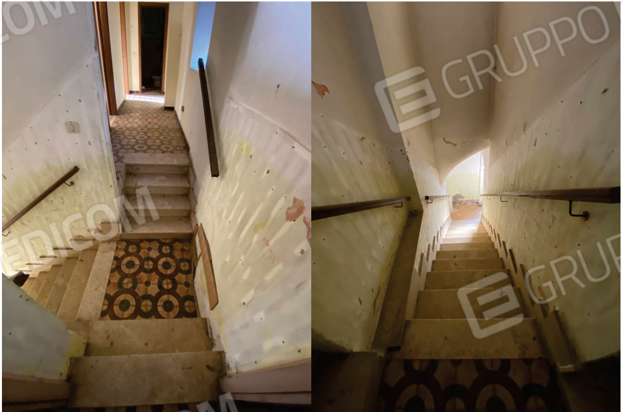
FOTO 8 : VISTA INTERNA VANO SCALA
