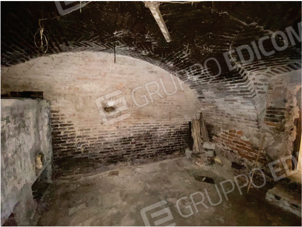
FOTO 7 : VISTA INTERNA CANTINA PIANO TERRENO
