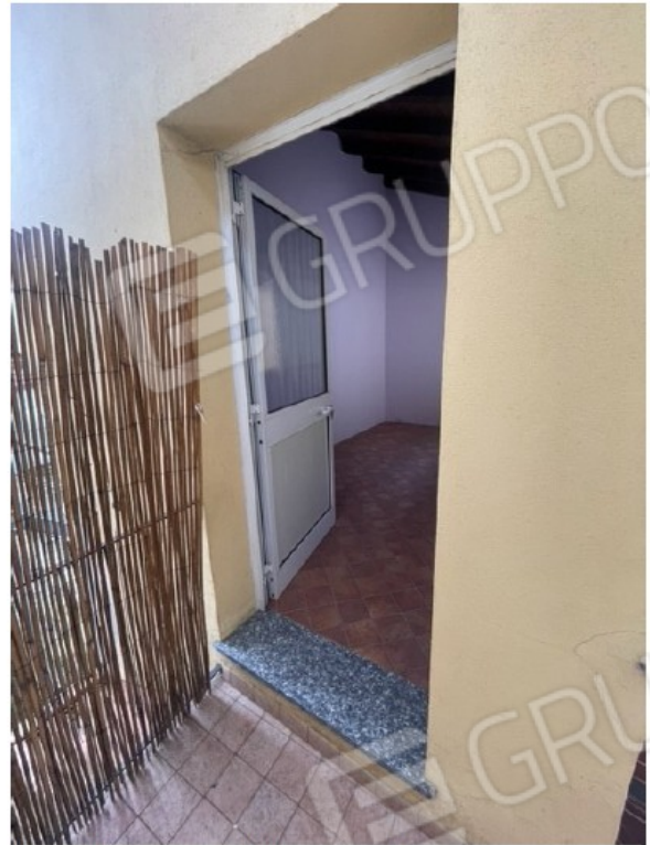
Figura 14. Ripostiglio al Piano Primo / Balcone.
