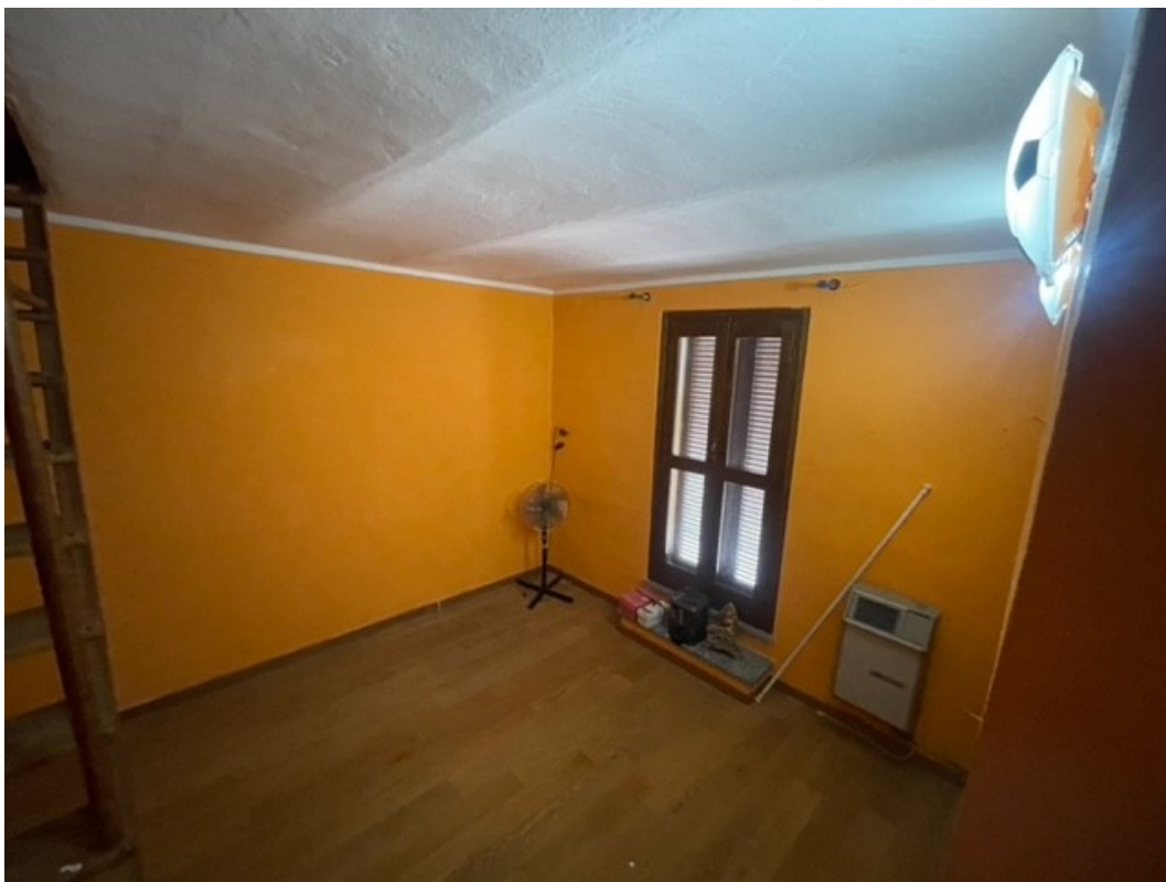
Figura 24. Camera 3 – Piano Primo.
