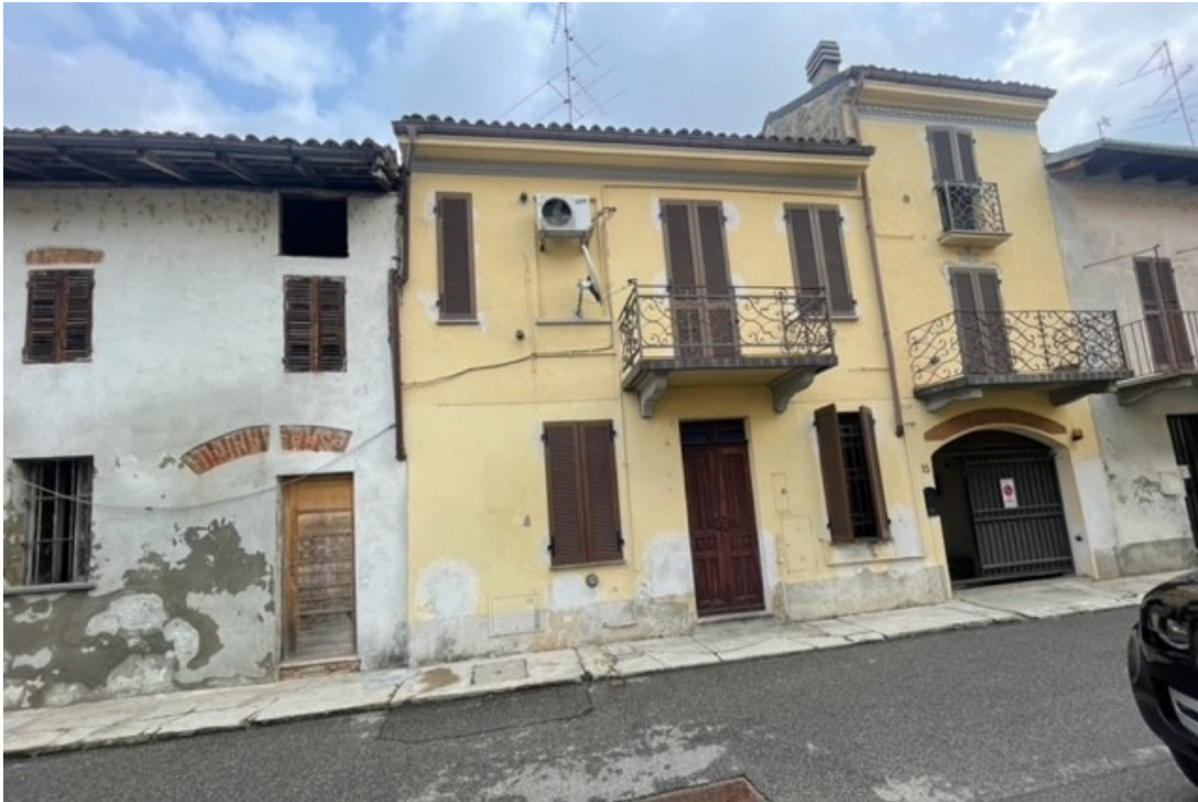
Figura 1. Facciata da Via Rattazzi
