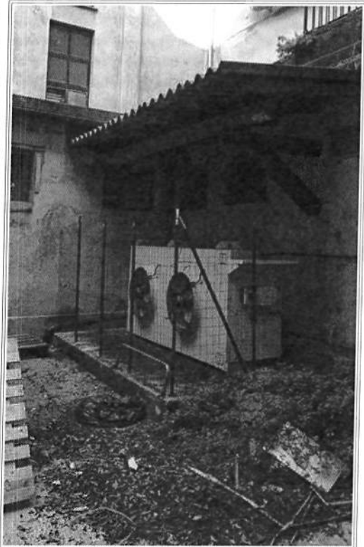
fotografia 1: pensilina, battuto di cemento e motori di pertinenza del negozio sub 18
