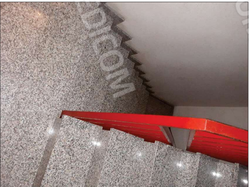
Vano scale comune
