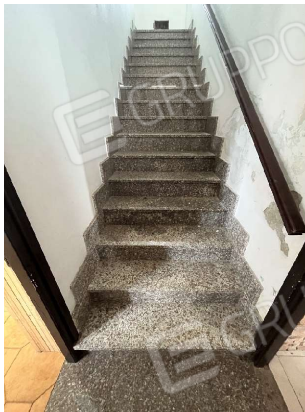
VISTA SCALA DI ACCESSO A P.1°
