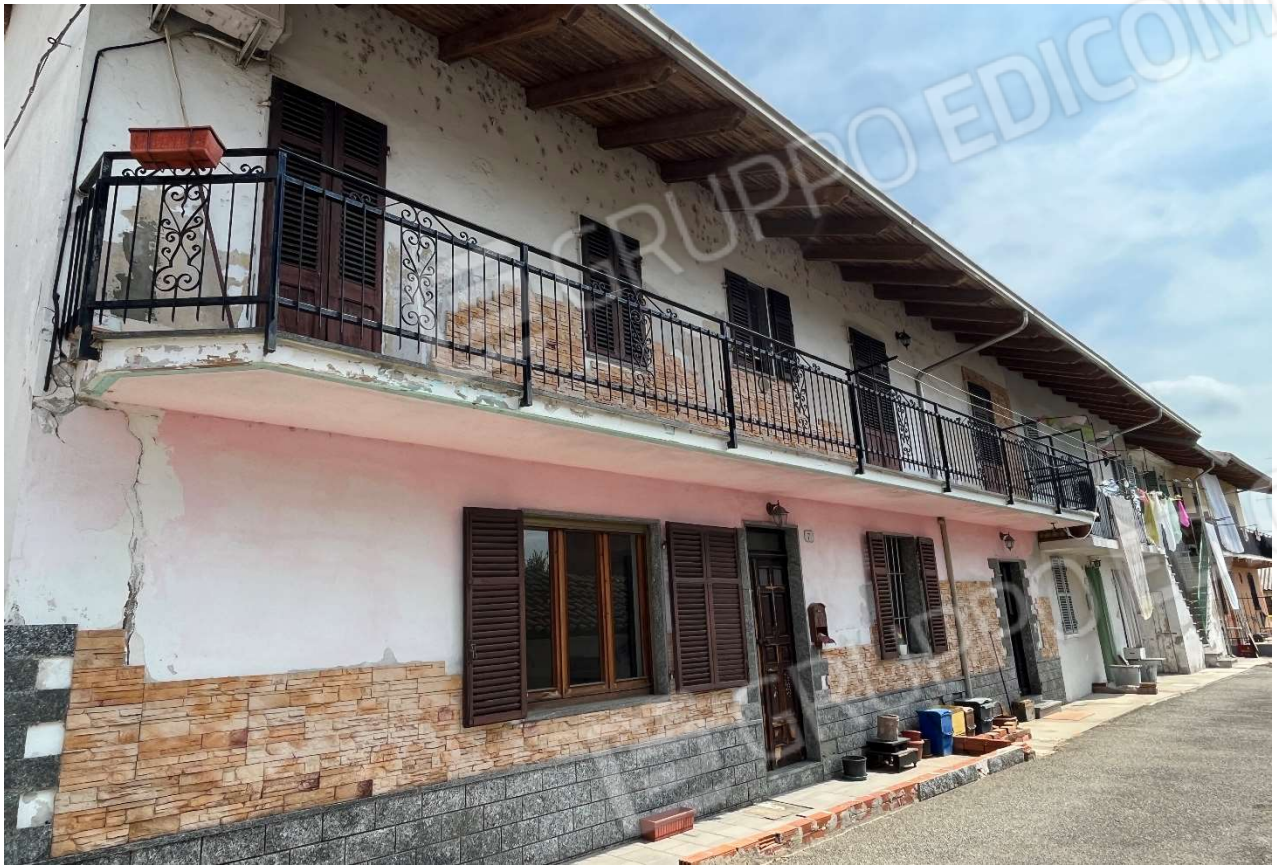
PROSPETTO SUD – Vista da ovest
