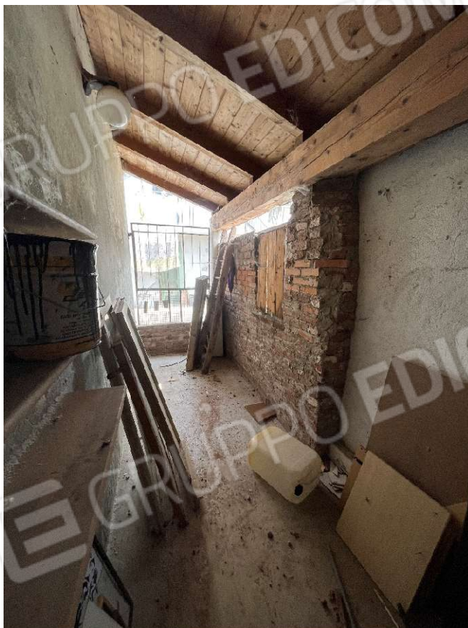
VISTA INTERNA TETTOIA A LATO AUTORIMESSA
