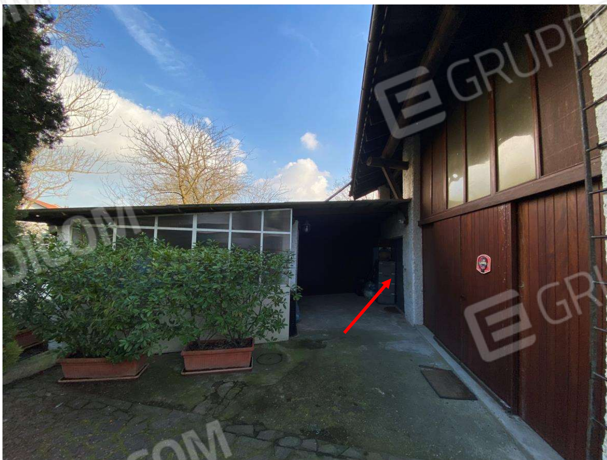
FOTO 22 : VISTA D'INSIEME ESTERNA LOCALE DI SGOMBERO
