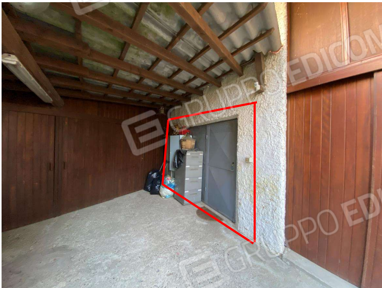
FOTO 21 : VISTA D'INSIEME ESTERNA LOCALE DI SGOMBERO
