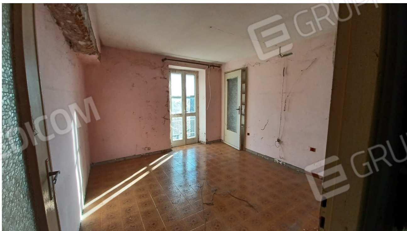
Foto 9 – camera piano primo
