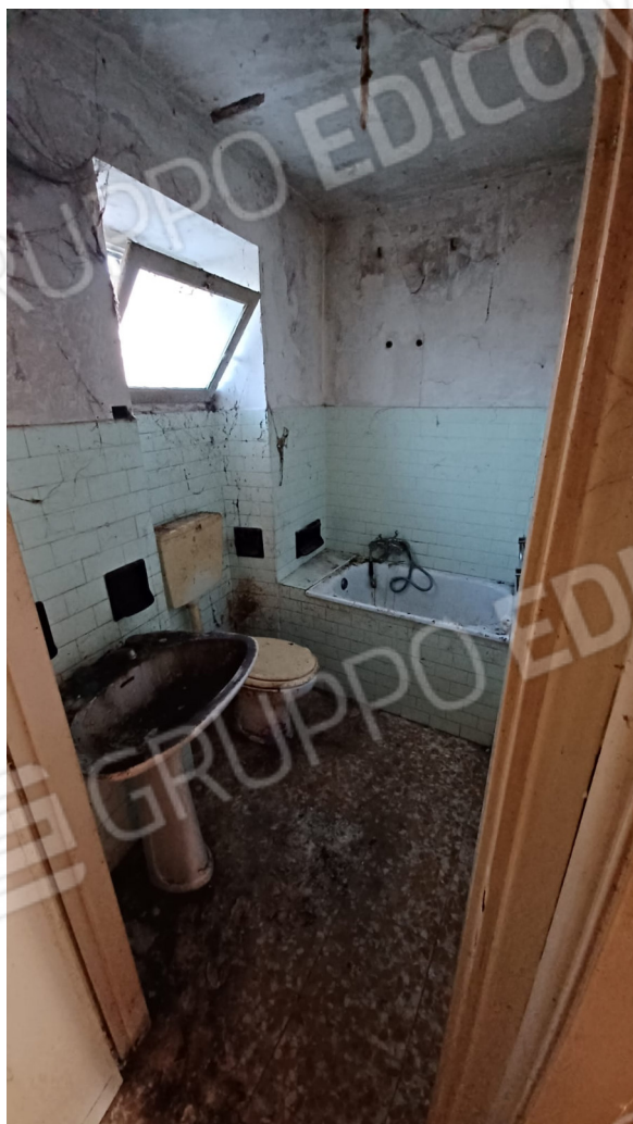
Foto 8 – bagno piano primo
