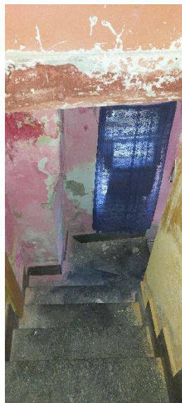
FOTO 15 – Vano scala di accesso al piano primo particella 682
