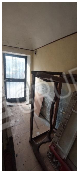
FOTO 31 – Ingresso civico 6 al piano terreno particella 711
