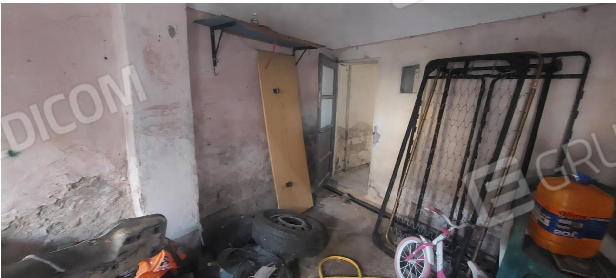
FOTO 27 – Ripostiglio al piano terreno particella 711
