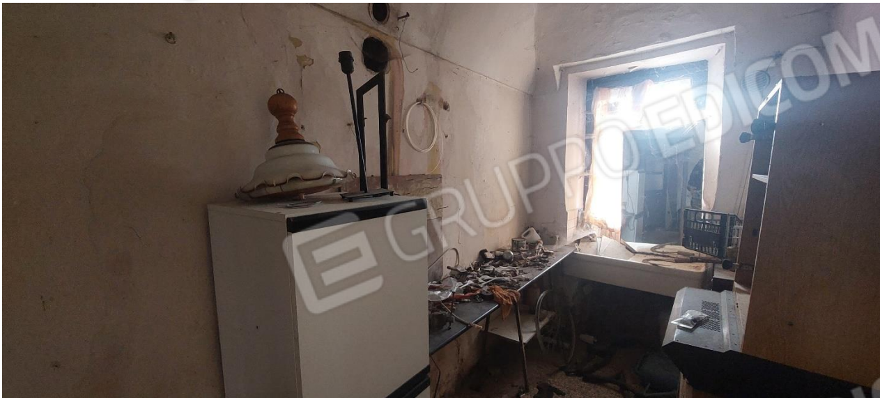
FOTO 28 – Camera al piano terreno particella 711
