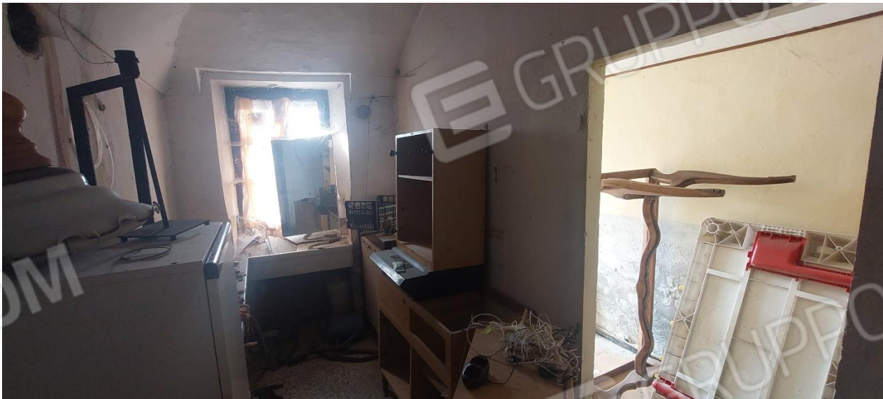
FOTO 29 – Camera al piano terreno particella 711
