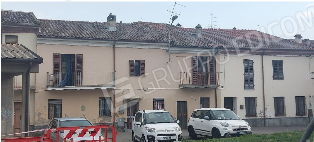
FOTO 1 – Facciate su Piazza IV Novembre
