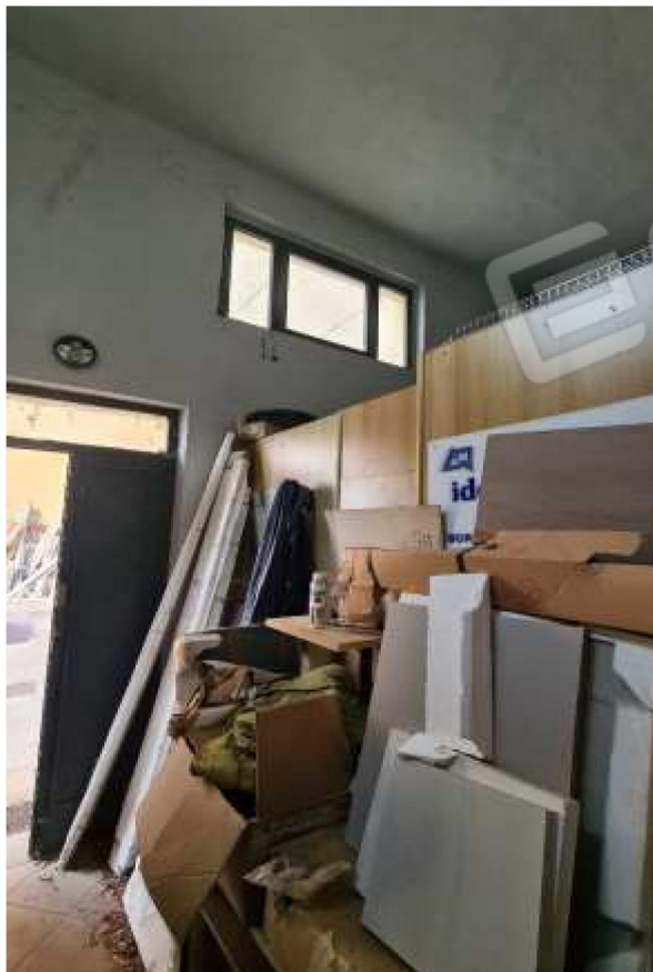
Locale di sgombero
