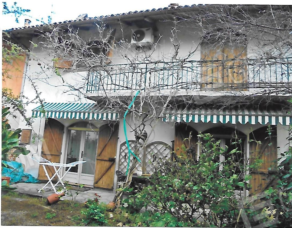
Foto 2 – Facciata interna su cortile
