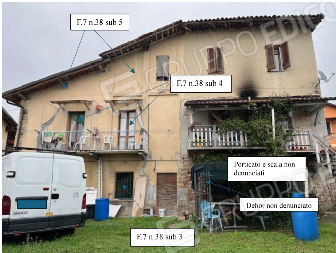
Vista fabbricato da retro con particelle F.7 n.38 sub 3, sub 4 e sub 5
