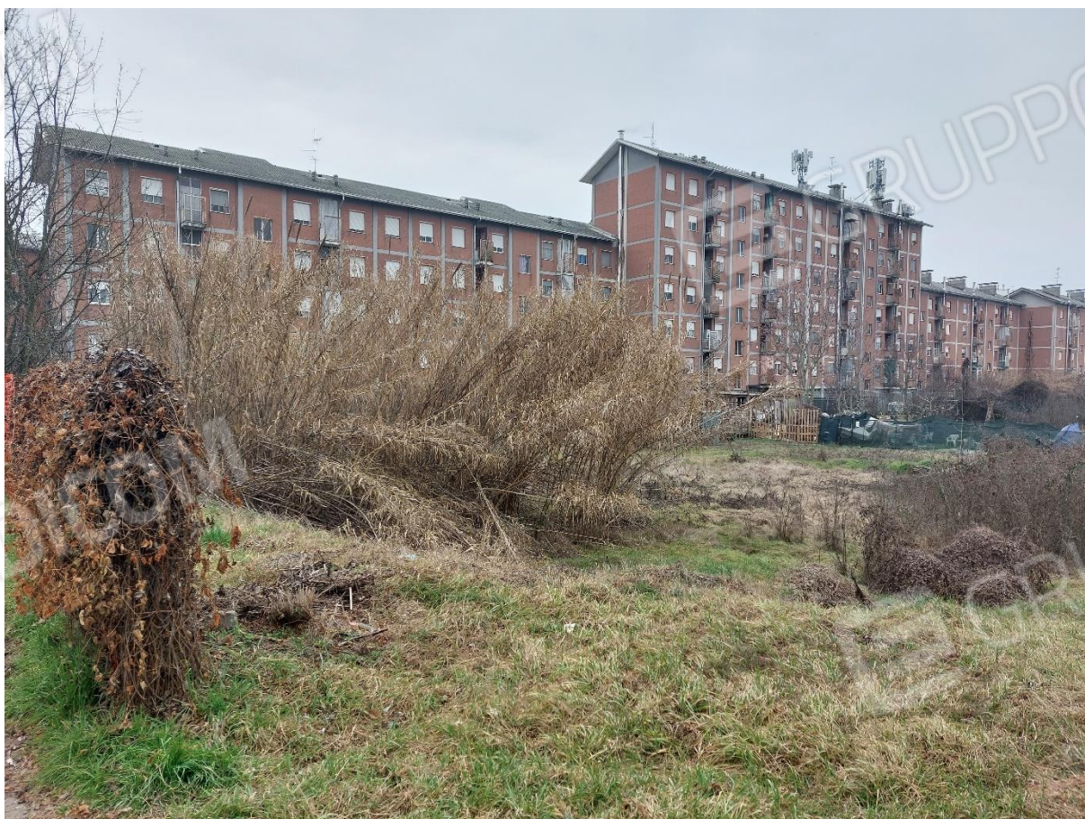
FOTO 4 – Foto da via Galimberti delle particelle 581-817-818 “ LOTTO 3 ”
