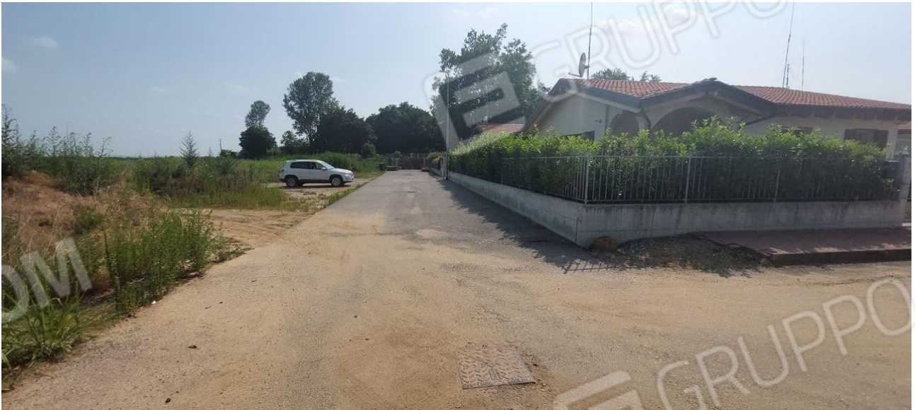
FOTO 4 – Strada realizzata sulla particella 240 – “ LOTTO 1 ”
