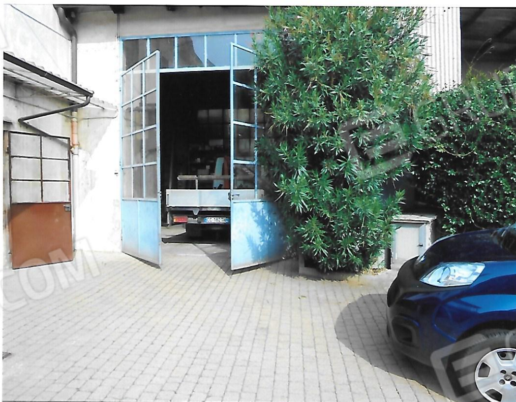
Foto 4 – Secondo prospetto da cortile su Via S.Lorenzo
