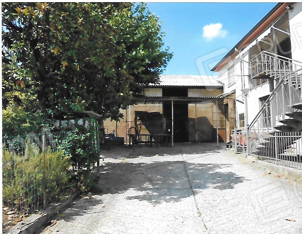
Foto 6 – Prospetto tettoia con avancorpo
