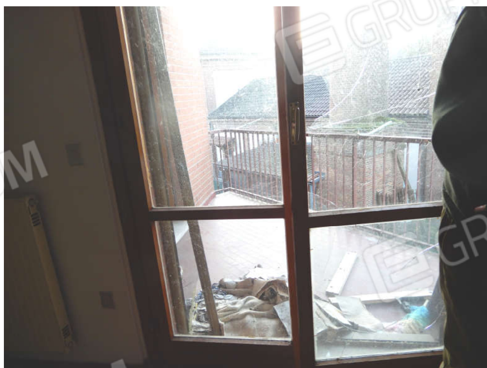
Piano primo – terrazzo fruibile sia dal bagno che dalla camera.
