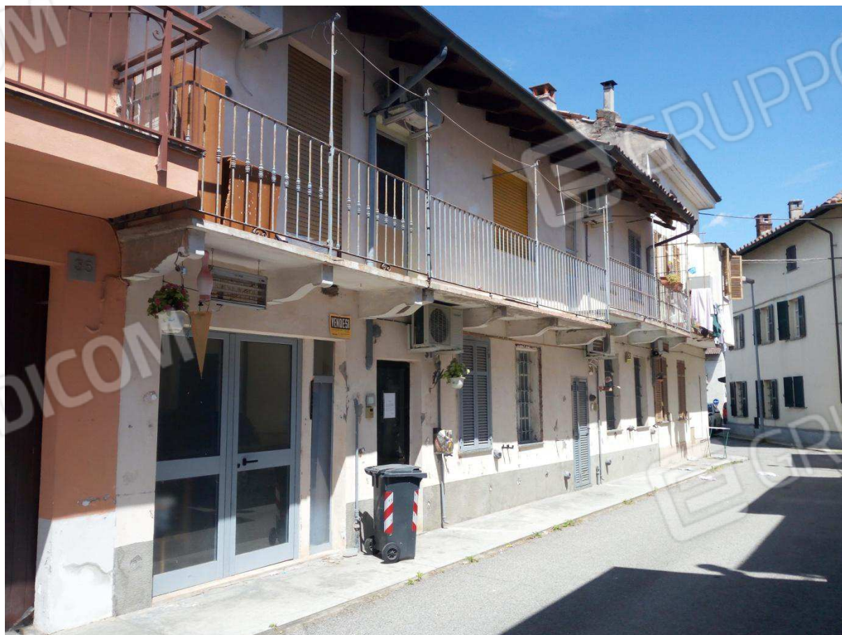
Immagine 2. Prospetto Sud (Lato Ovest) - Accesso al compendio pignorato del 14/05/2019
