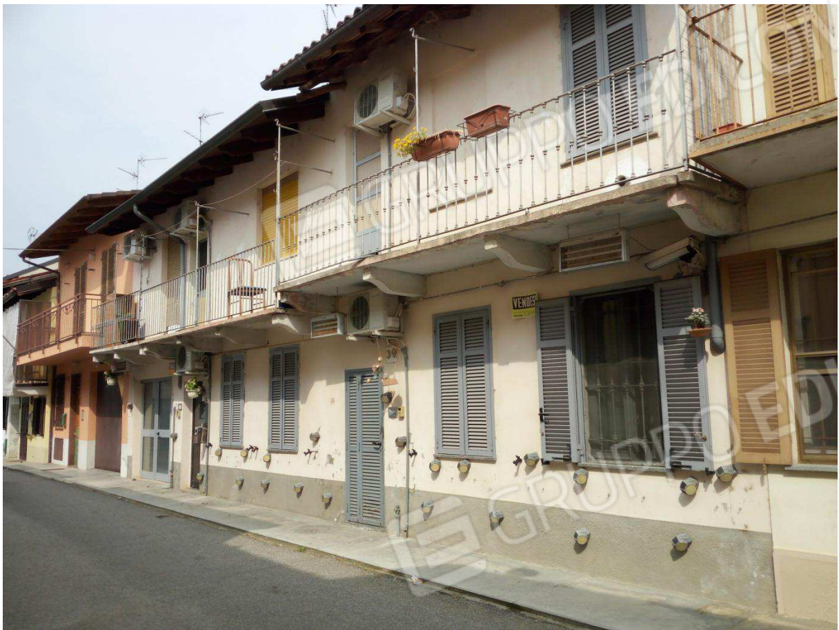
Immagine 3. Prospetto Sud (Lato Est) - Ispezione preliminare del 10/04/2019
