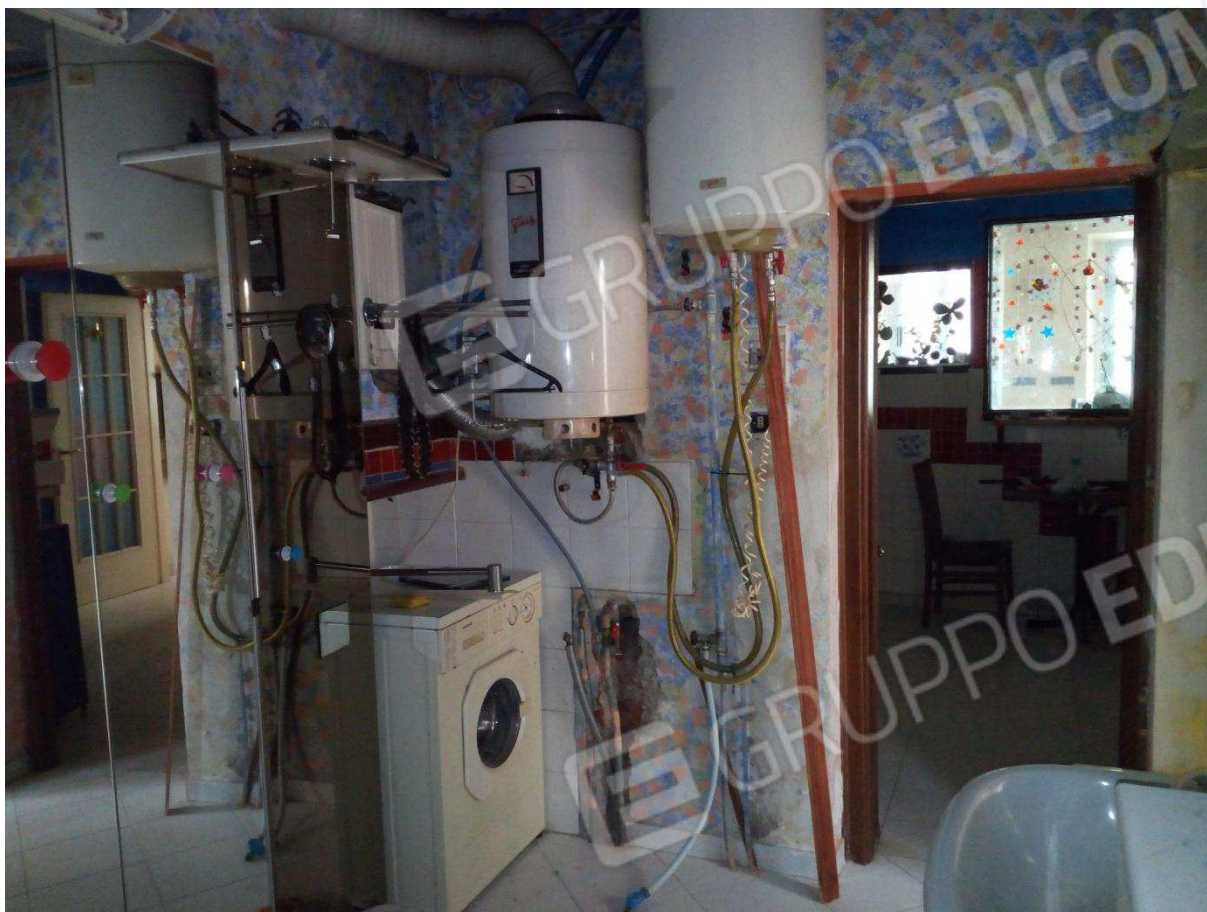
Immagine 29. Locale n. 10 (Bagno n. 1)
