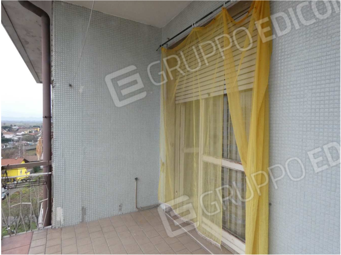
13. Esterno balcone su Via Pretti
