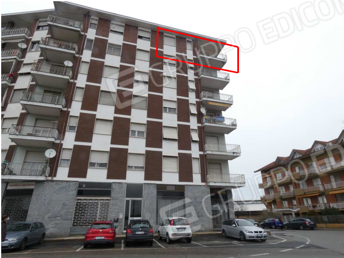
1. Prospetto sud su Corso Aosta
