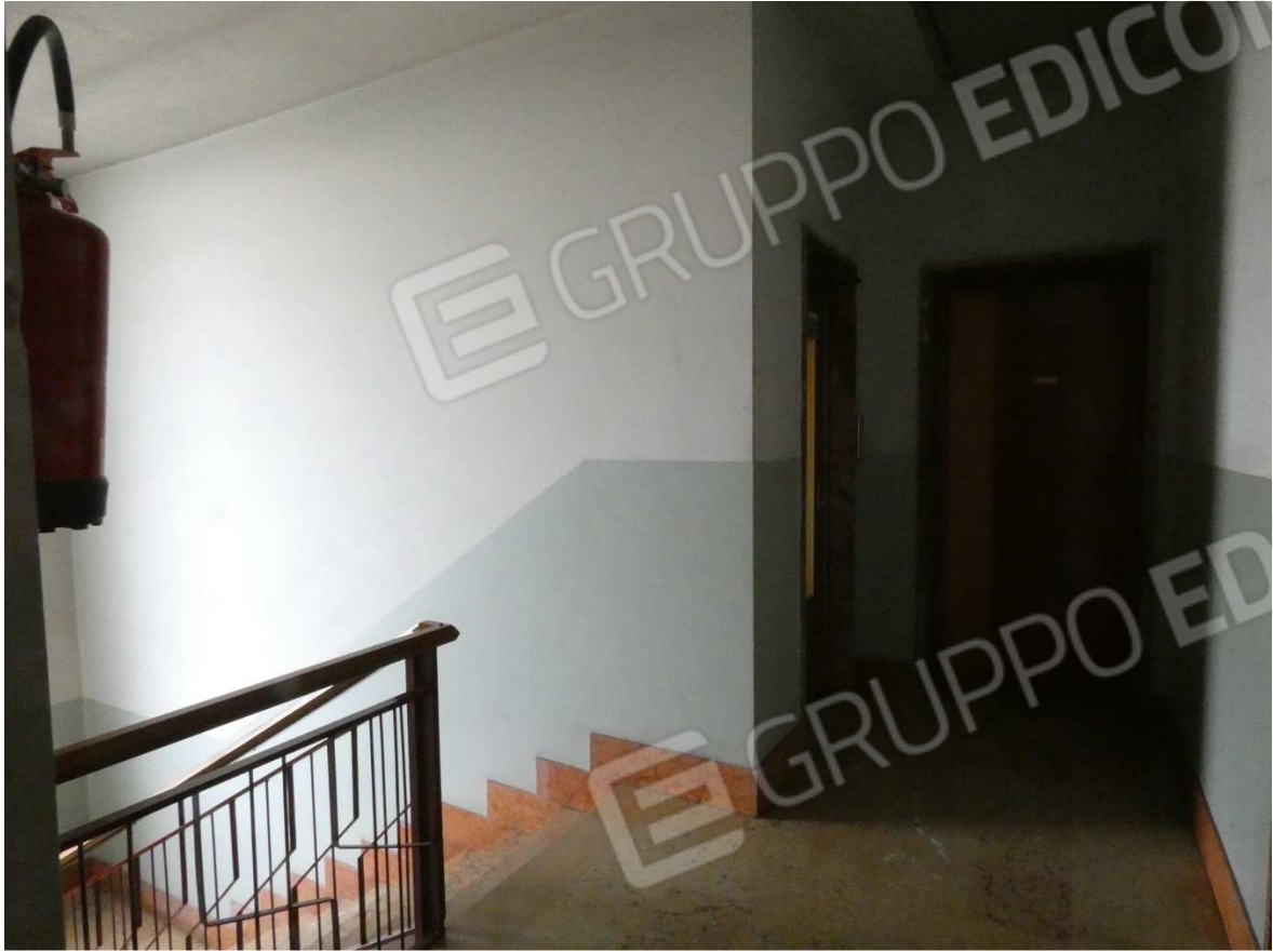
3. Pianerottolo piano sesto scala "B"
