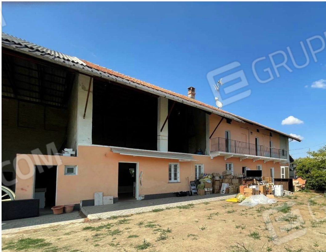
Foto 2 – Vista generale dell'abitazione dal cortile
