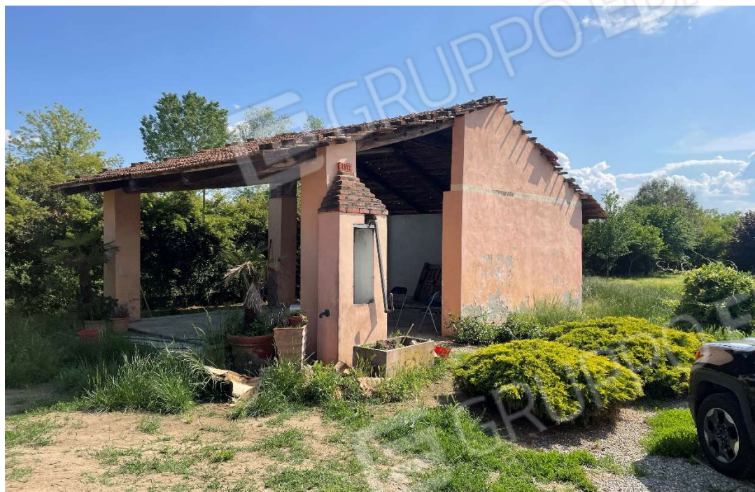
Foto 3 – Vista generale della tettoia isolata
