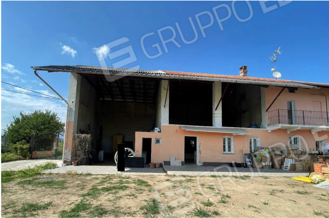
Foto 1 – Vista generale dell'abitazione dal cortile
