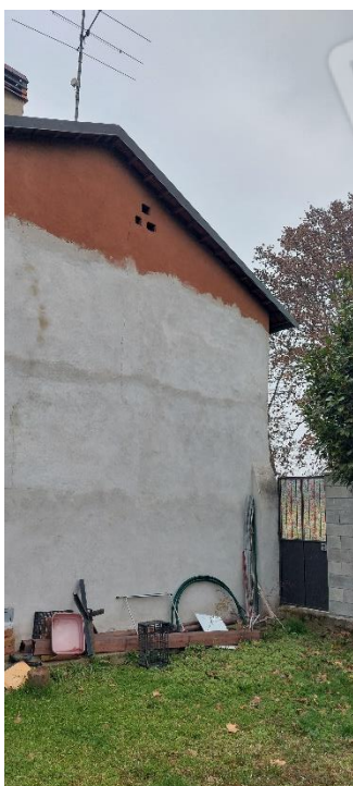
FOTO 11 – Prospetto lato est
