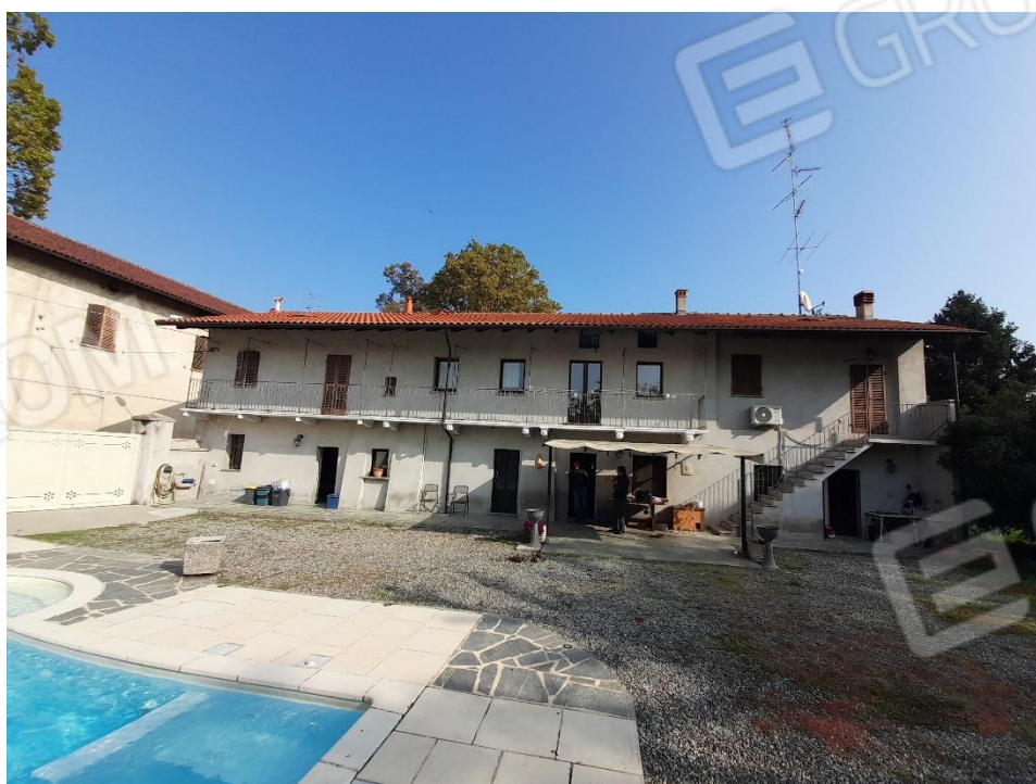
FOTO 6 – Prospetto lato sud interno cortile
