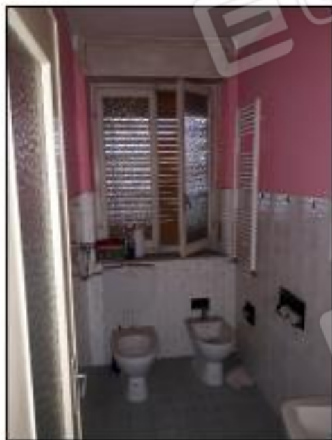
21 - Bagno piano primo
