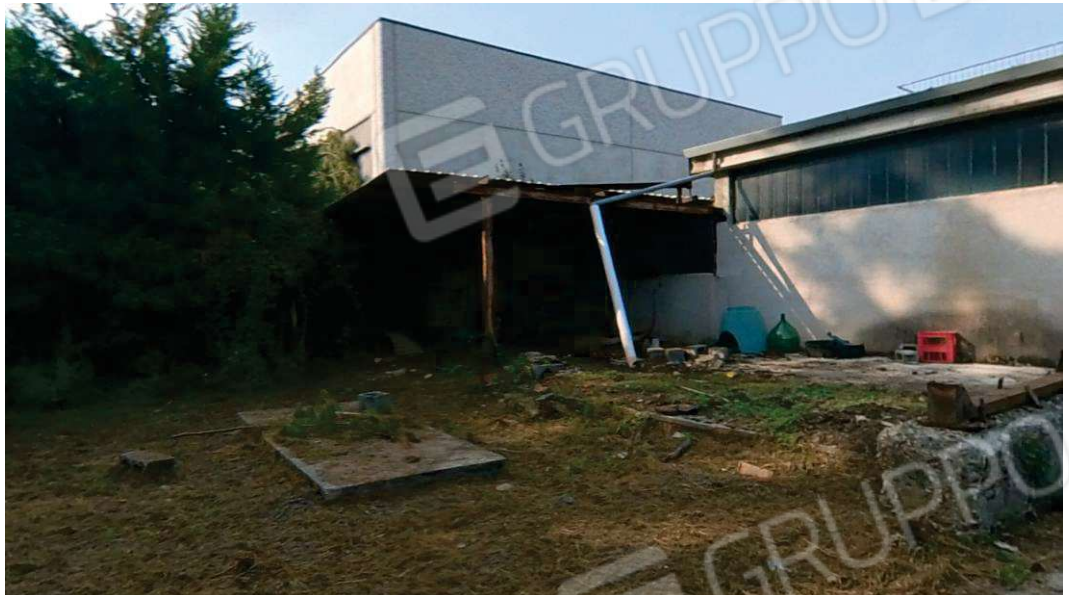
Foto 26 – Cortile Posteriore e Tettoia
