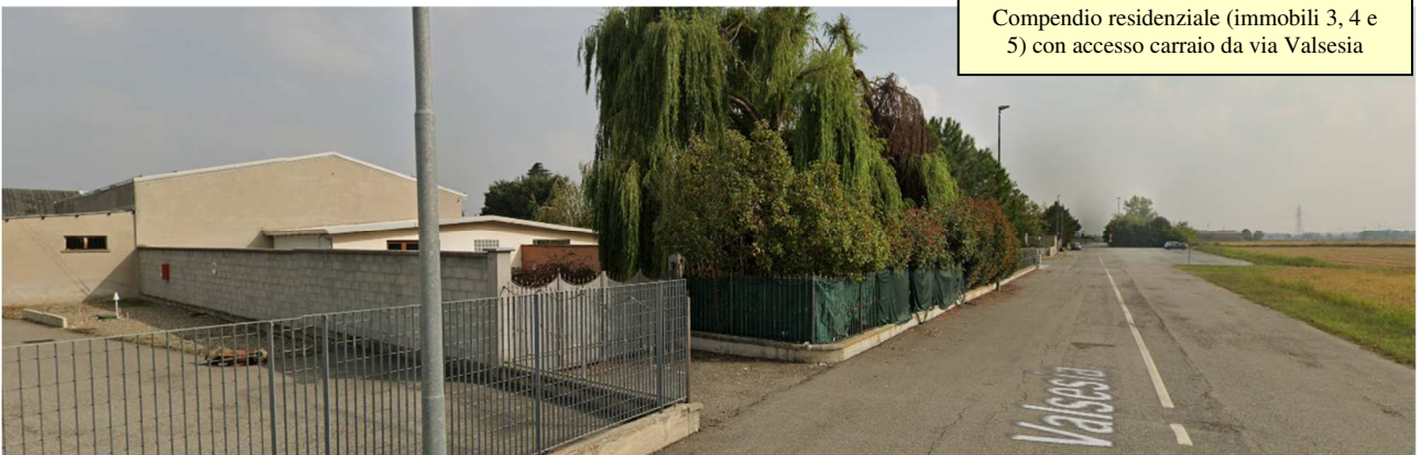
Compendio residenziale – muro di separazione villetta/piscina
