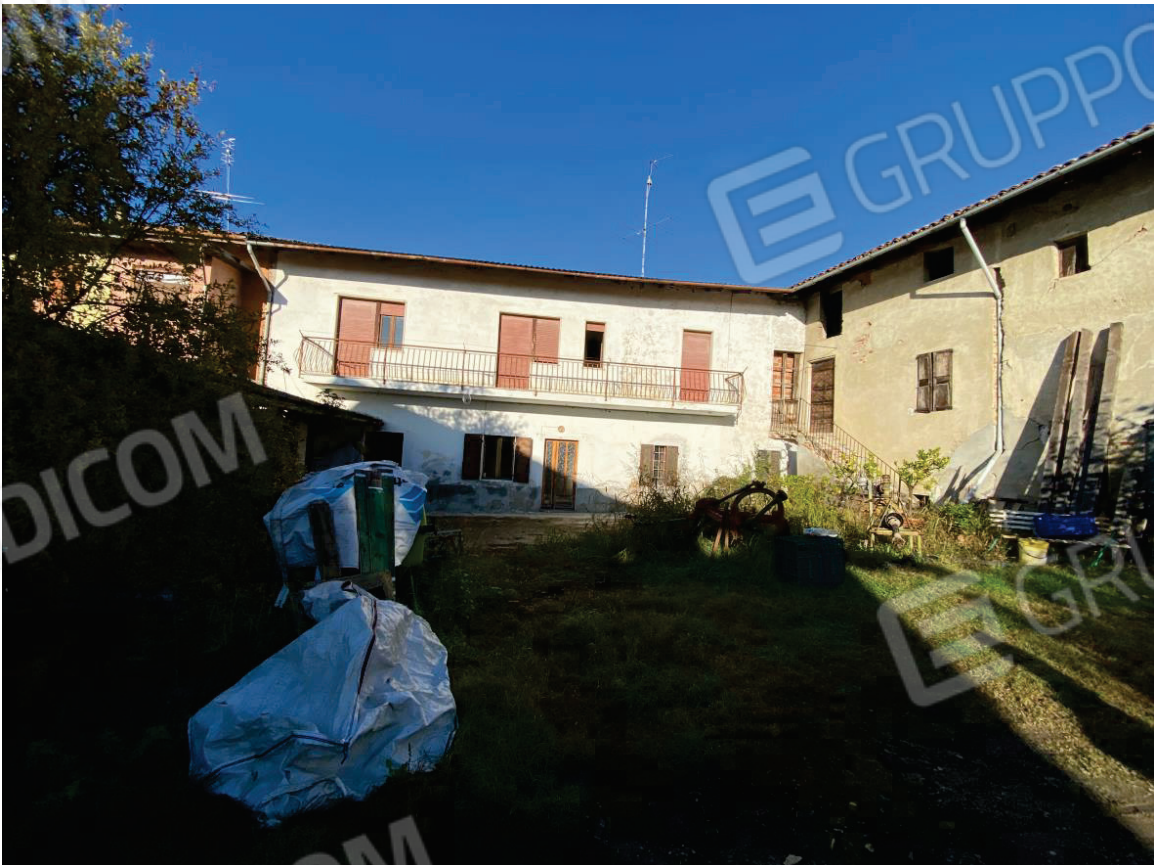
FOTO 2 : VISTA ESTERNA LATO CORTILE INTERNO
