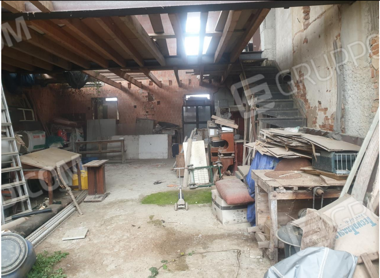
Foto 37: vista interna da ingresso
