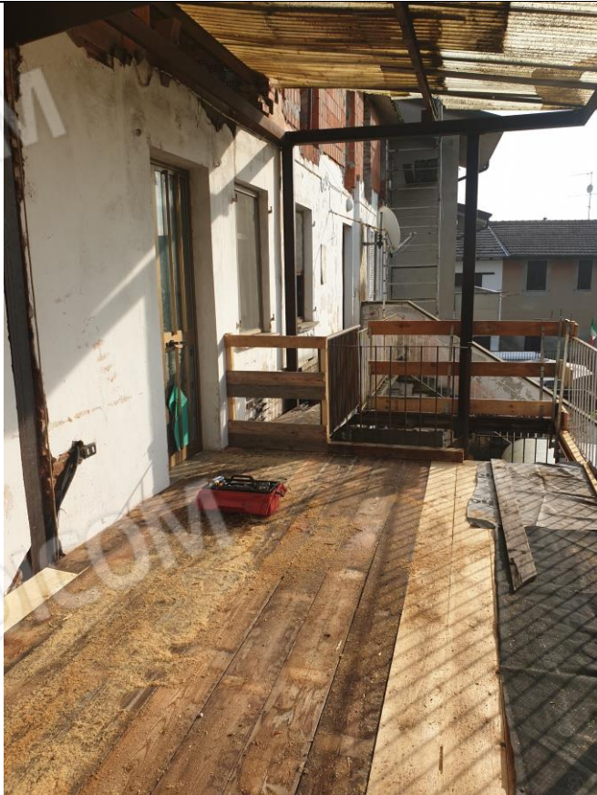
Foto 05: Accesso da ballatoio ampliato piano primo
