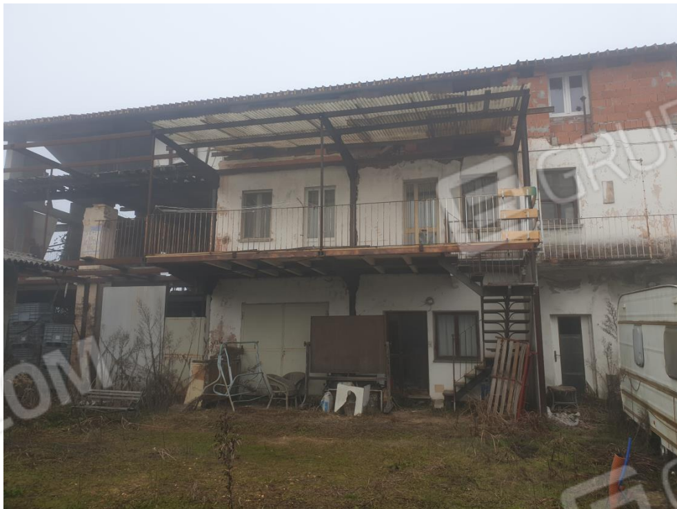
Foto 03: Vista da cortile interno
