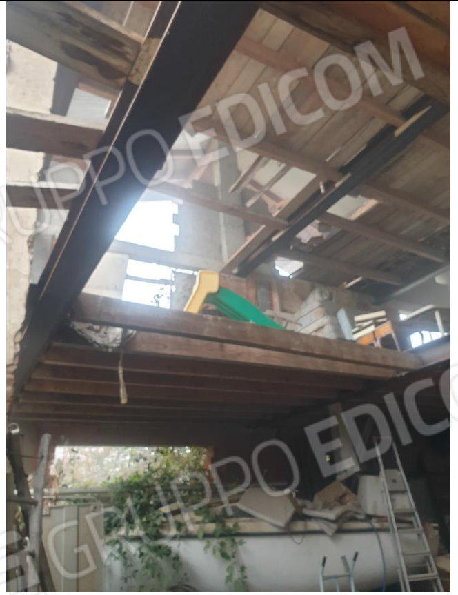
Foto 39: soppalchi e strutture viste dall'interno
