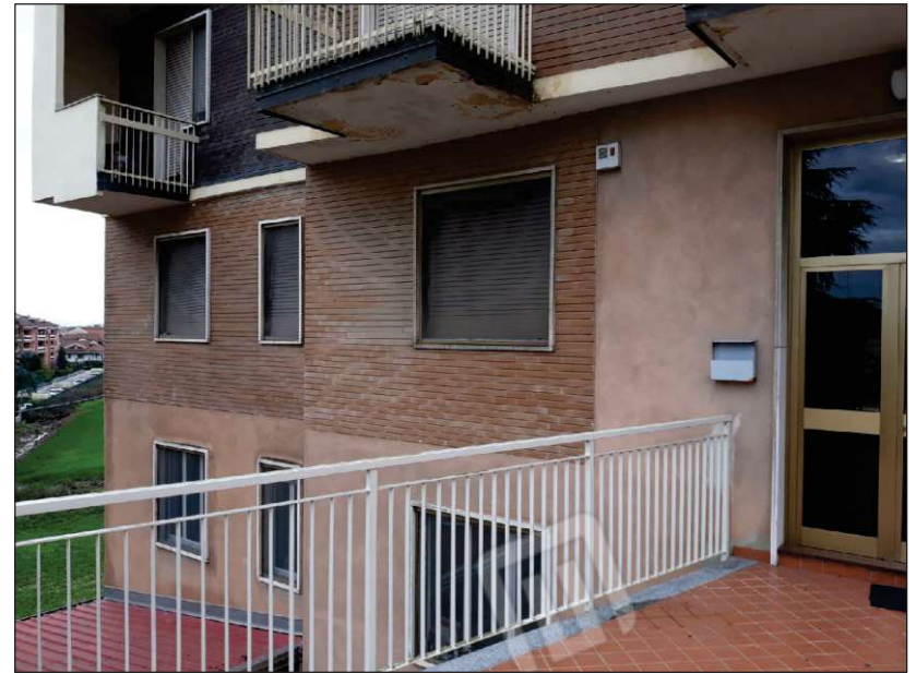
Particolare facciata Nord alloggio
