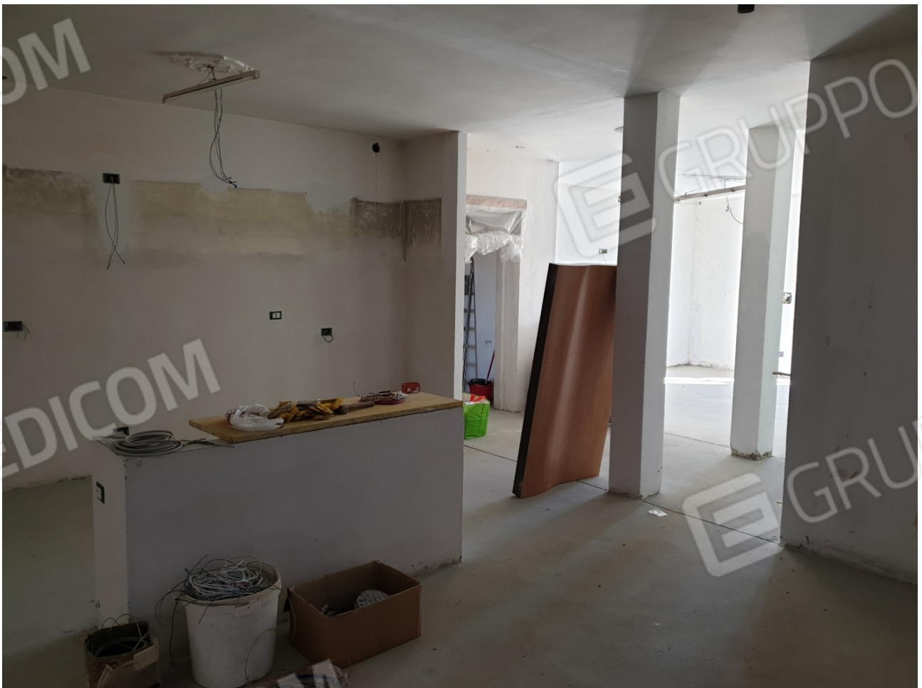
PRIMO PIANO PARTE IN RISTRUTTURAZIONE
