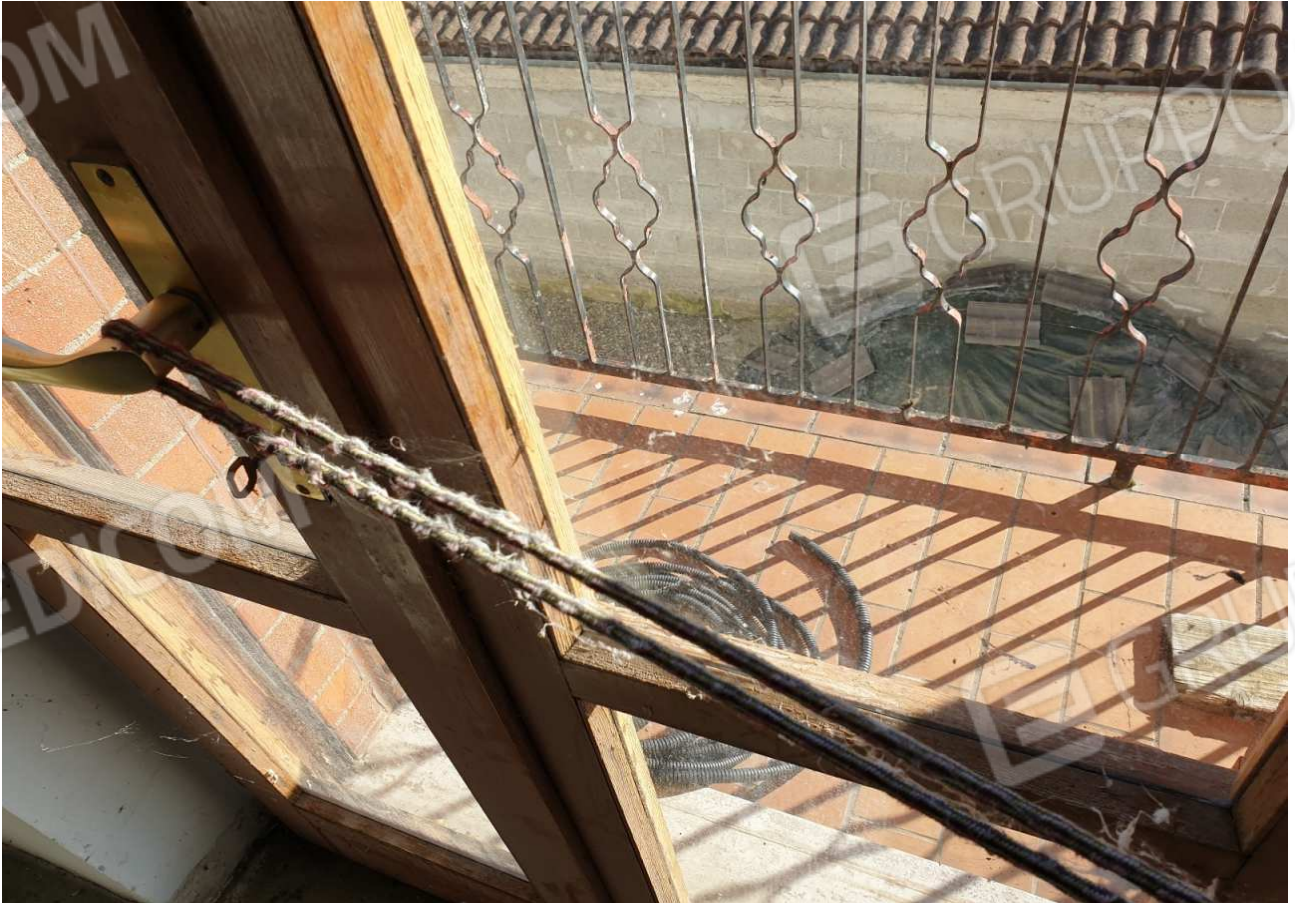
PRIMO PIANO PARTICOLARE DEL SERRAMENTO
