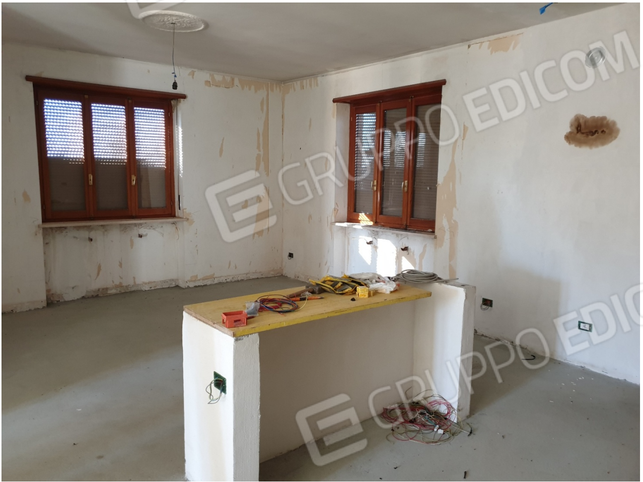
PRIMO PIANO PARTE IN RISTRUTTURAZIONE
