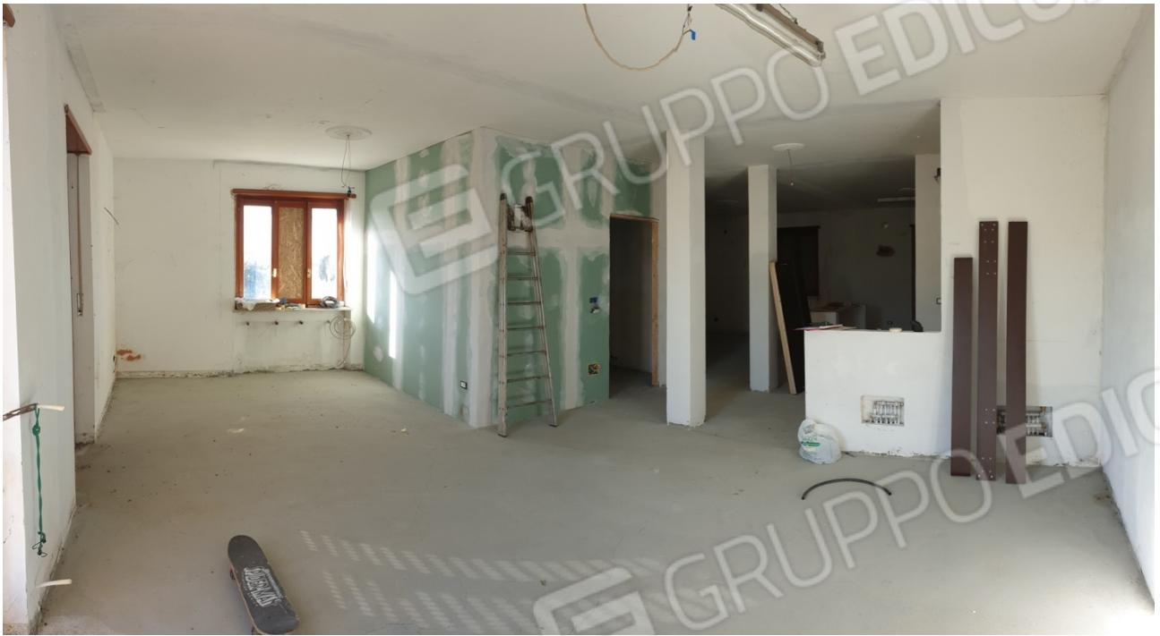
PRIMO PIANO PARTE IN RISTRUTTURAZIONE
