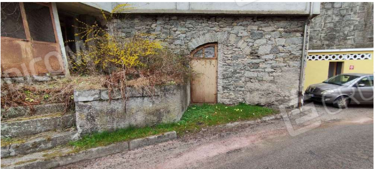
Ingresso locale caldaia
