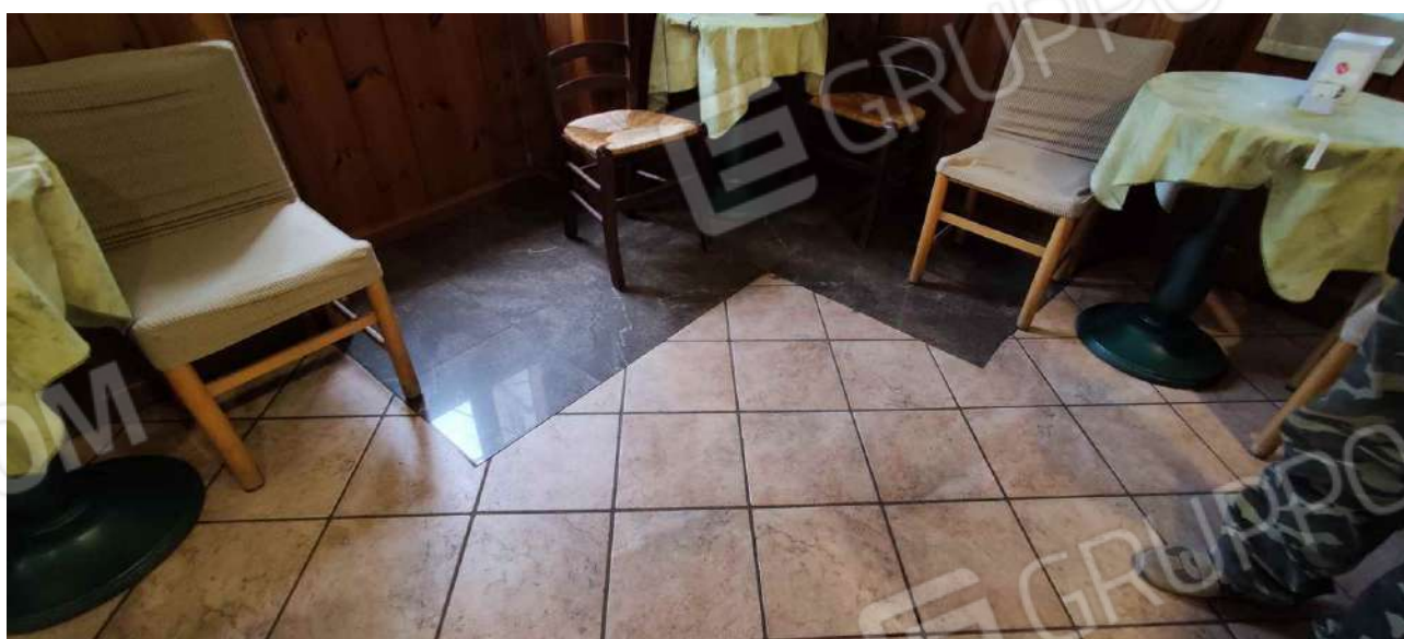
Porzione di solaio chiusa per eliminazione scala
