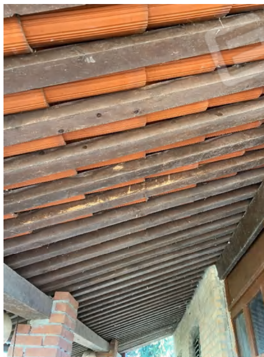
PORTICATO manto di copertura
