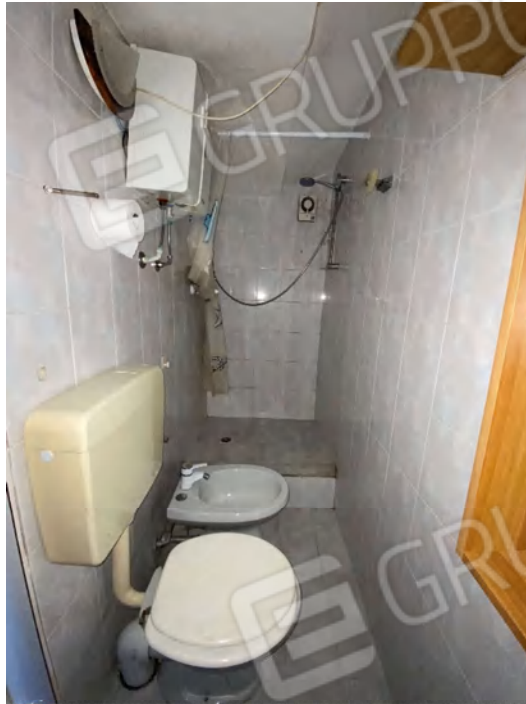
BAGNO (B) (SUB. 5) pavimento e rivestimento pareti
