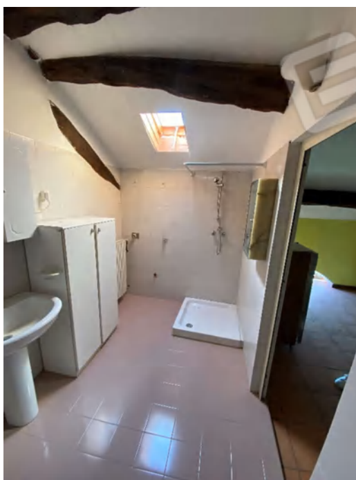
BAGNO (SUB. 9) pavimento, rivestimento e soffitto
