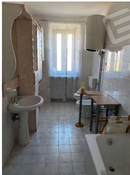
BAGNO (SUB 6) pavimento e rivestimento
