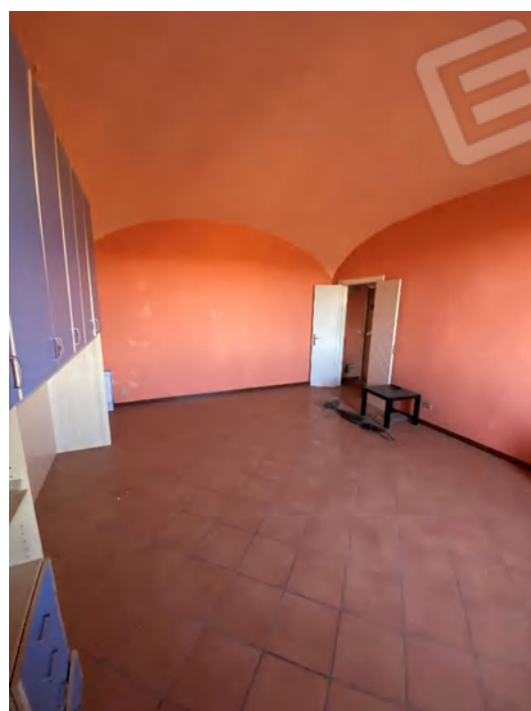
CAMERA "A,, (SUB. 5) pavimento e soffitto
