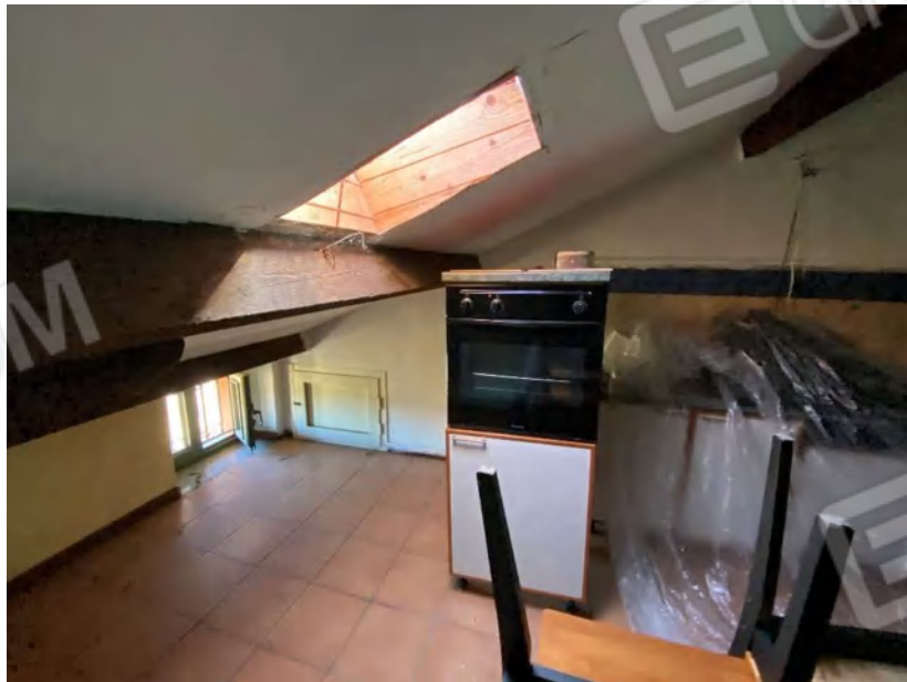
CUCINA/CAMERA (SUB 10) pavimento e soffitto
