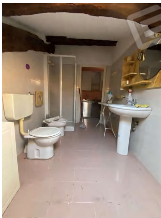
BAGNO (SUB. 8) pavimento, rivestimento e soffitto
