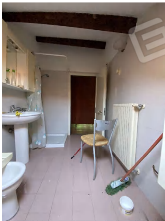
BAGNO (SUB. 10) pavimento, rivestimento e soffitto
