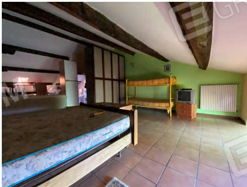
CUCINA/CAMERA (SUB 10) pavimento e soffitto
