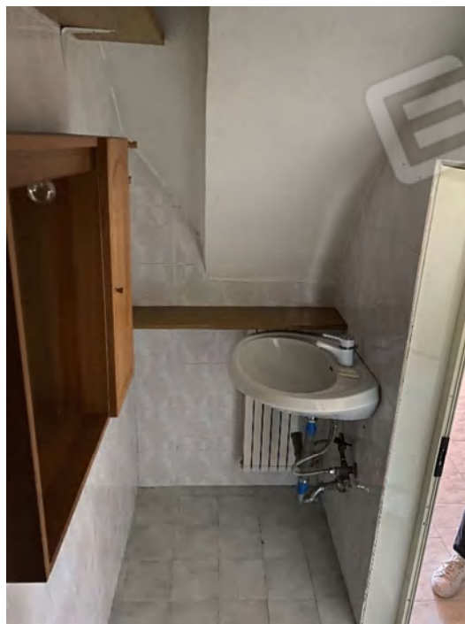
BAGNO (B) (SUB. 5) soffitto
